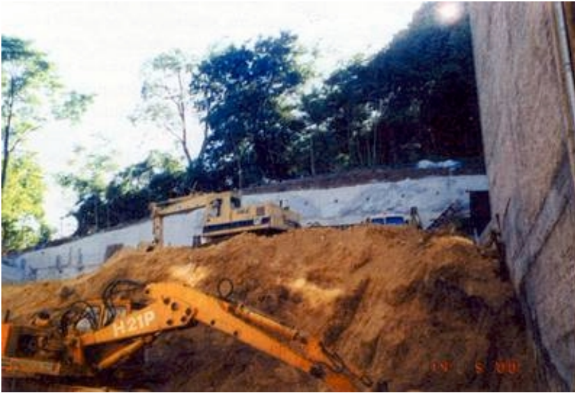
Iskop građevne jame krajem svibnja 2000.
