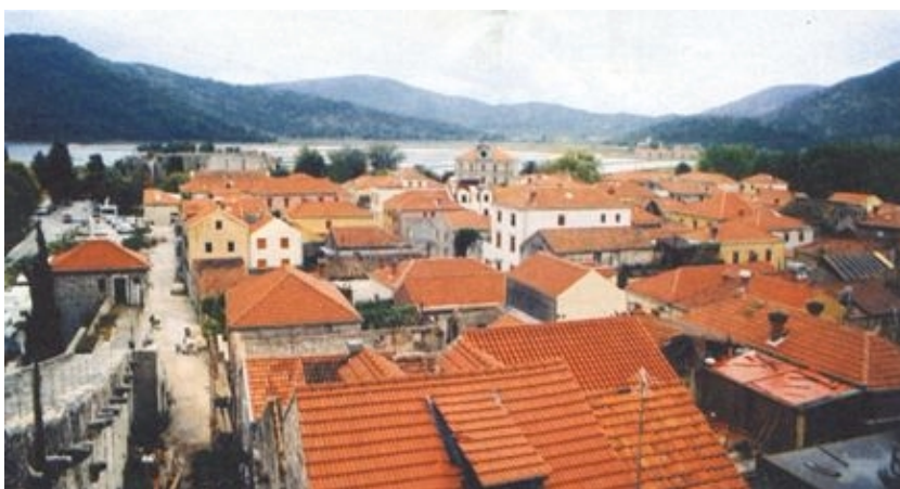
Pogled na obnovljene stonske krovove
