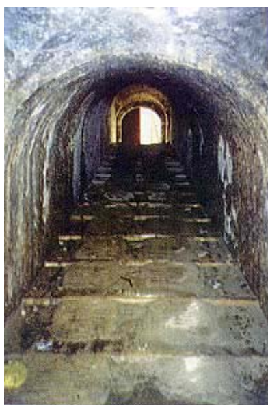
Stubište za izlaz na terasu tvrđave
