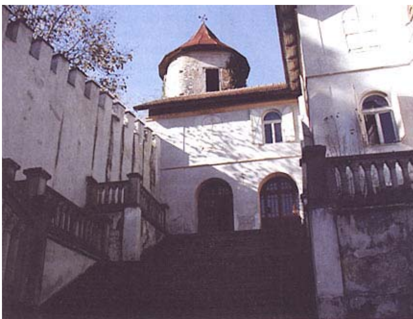
Prilazno stubište kapelici i kuli dvorca u Bosiljevu
