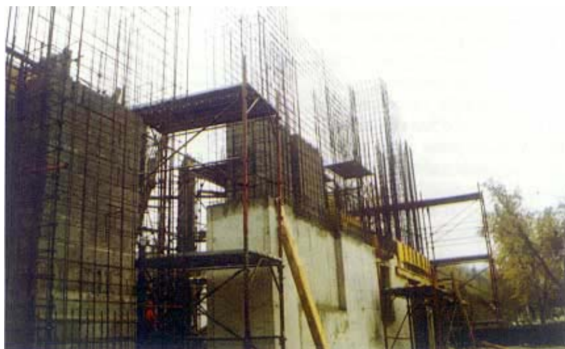
Izgradnja glavnog nosivog zida u (studeni 2001.)
