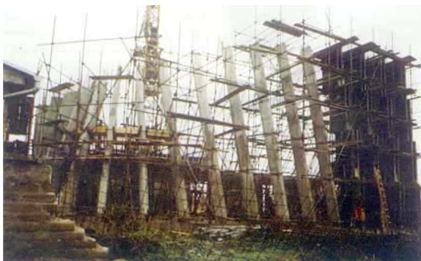
Montaža skele i stupova
