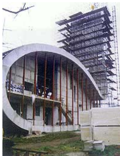
Bočni pogled na crkvu u izgradnji
