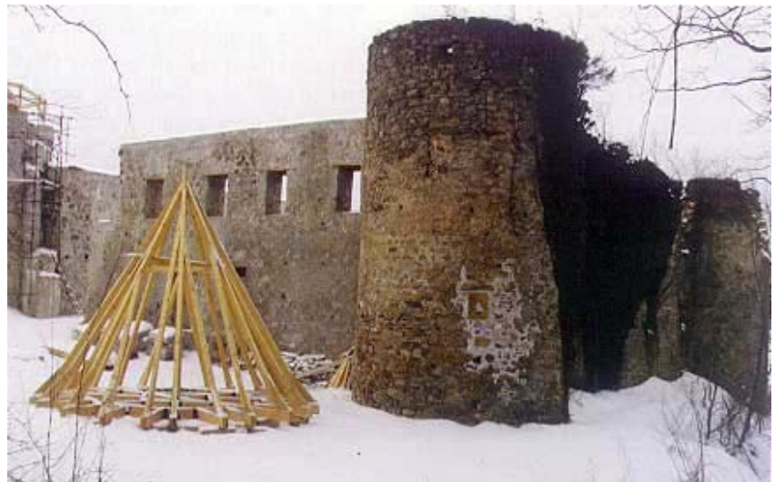
Obnovljeni dio unutrašnjosti novigradske utvrde
