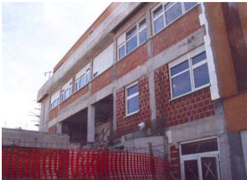
Radovi na dilataciji A1
