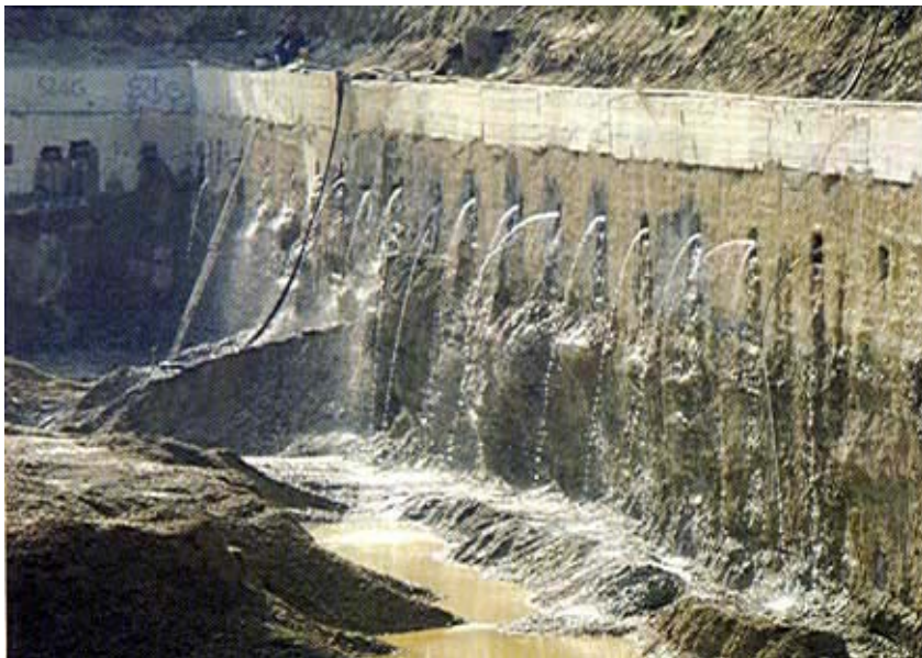
Pogled na građevnu jamu u fazi izvedbe dijafragme
