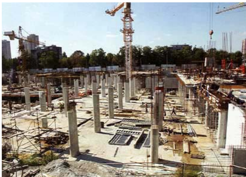
Radovi na podzemnom dijelu građevine
