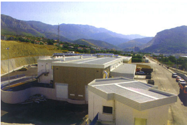
Gradevine Uredaja za pročišćavanje otpadnih voda Stupe
