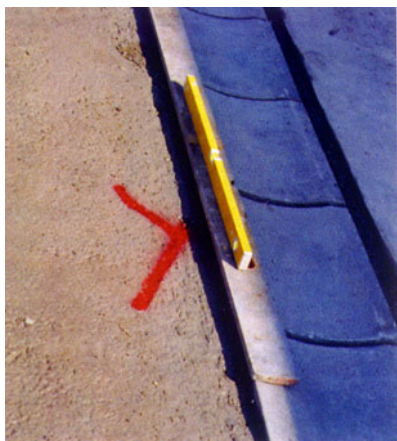
Polaganje elmenata odvodnog jarka
