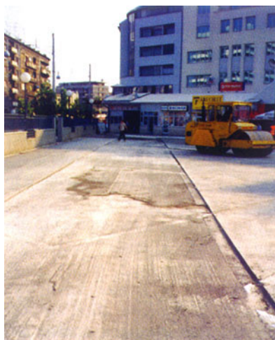
Skidanje dijela asfalta radi izravnjanja
