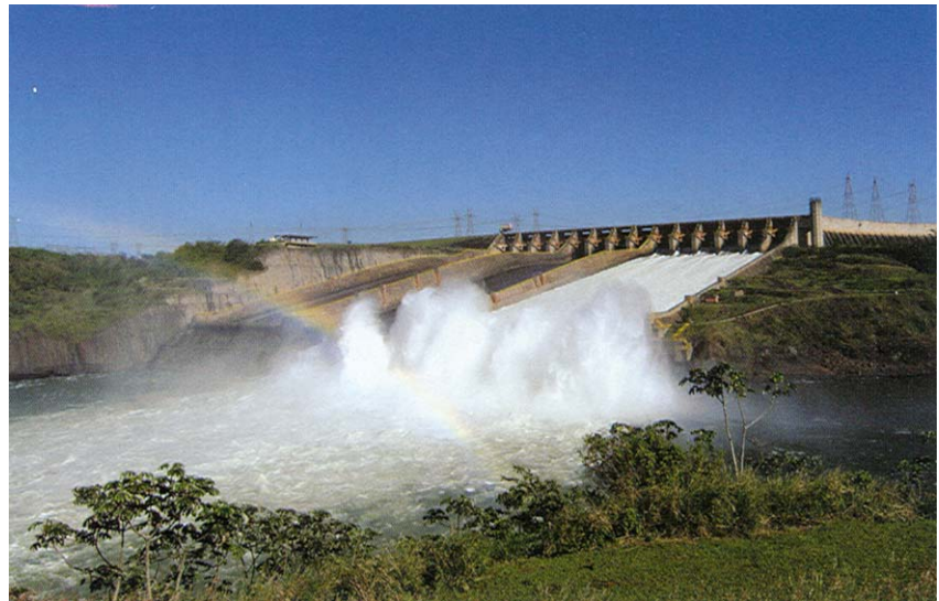
Ispuštanje vode kroz preljev
