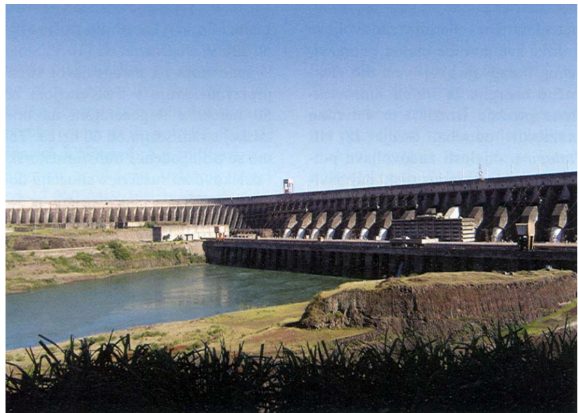
Glavna brana sa strojarnicom
