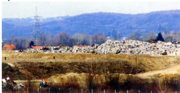
Slika 3. Deponija Trebež uzvodno od vodocrpilišta Strmec
