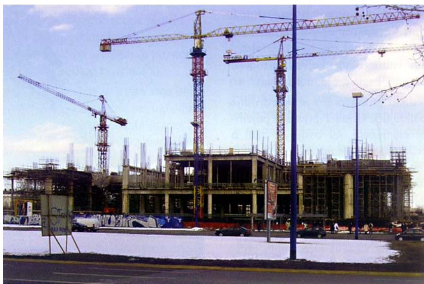
Pogled na gradilište iz Avenije Većeslava Holjevca
