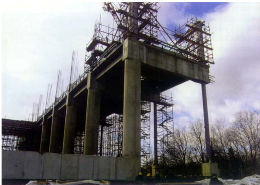
Izvedba sjeverne konzole s privremenim stupovima na pilotima
