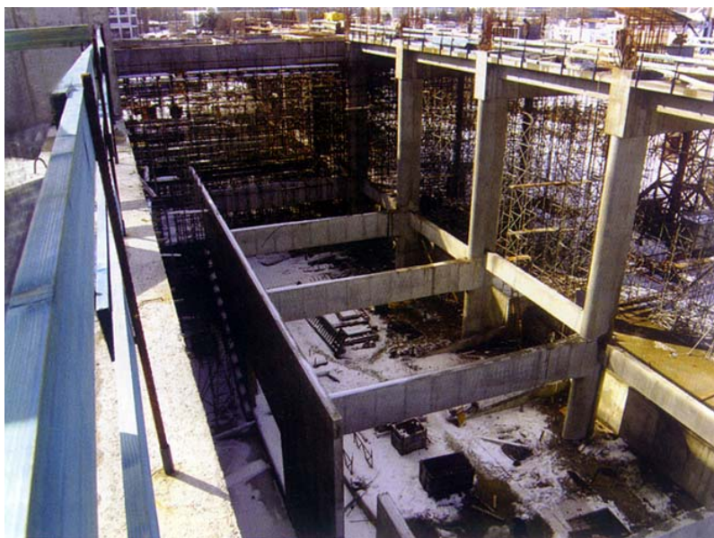
Unutrašnjost gradilišta snimljena odozgo
