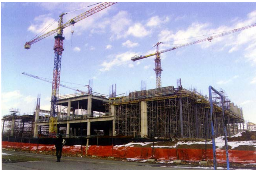
Pogled na gradilište iz Dubrovačke avenije
