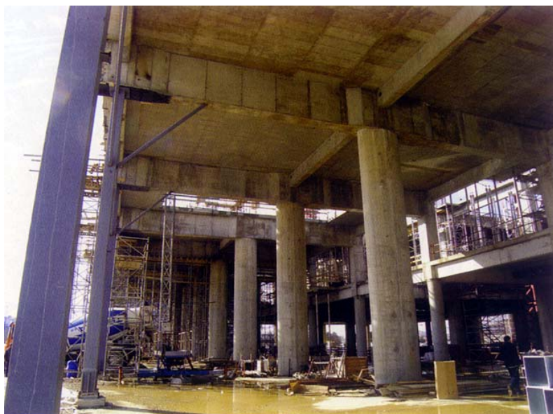
Dio gradilišta ispod konzole nad glavnim ulazom
