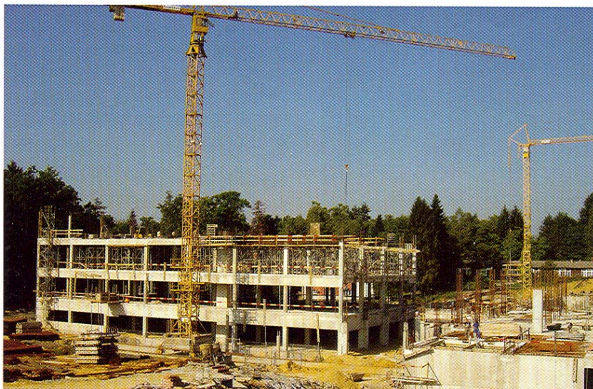
Radovi na dilataciji D (rujan 2004.)
