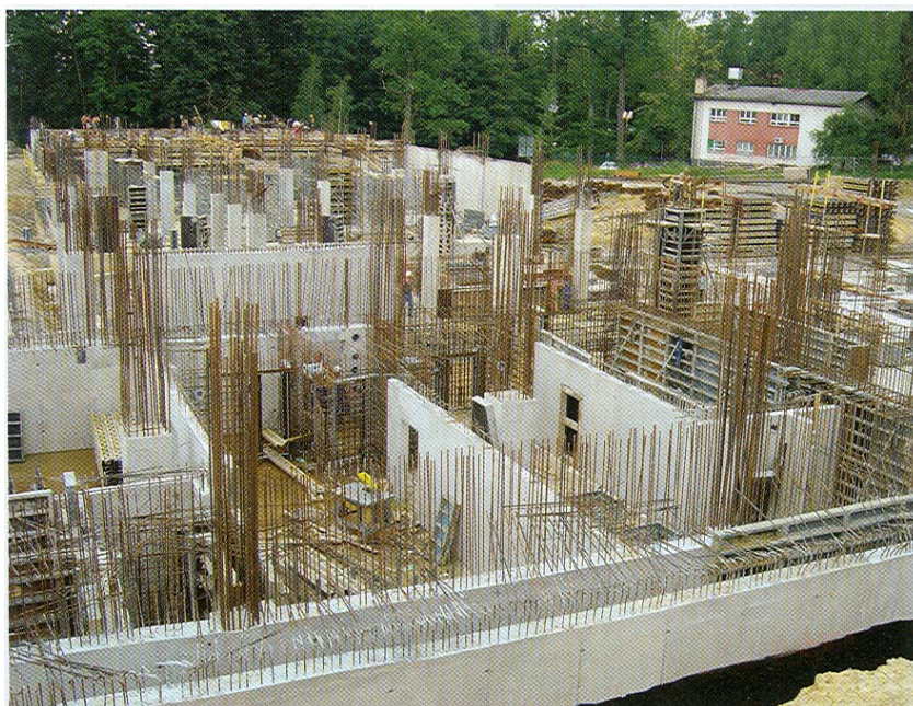
Početak betonskih radova (kraj lipnja 2004.)
