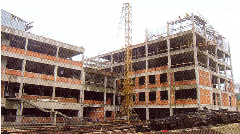
Pogled s istoka na dio gradilišta
