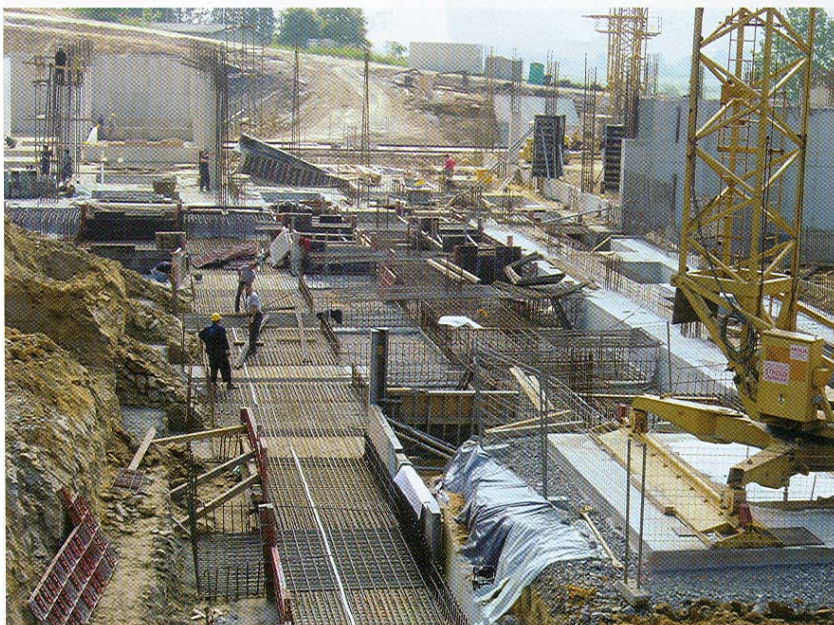
Detalj s početka radova (početak lipnja 2004.)
