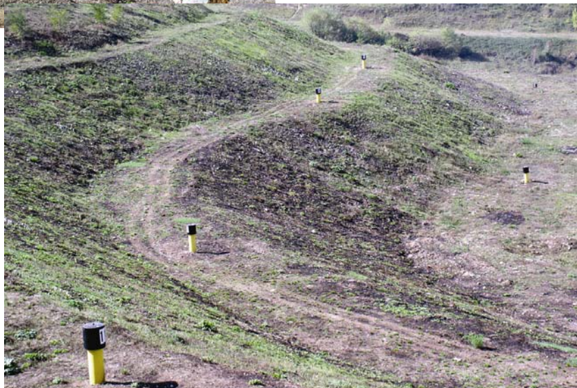
Sanirani dio zasaden travom i opremljen cijevima za otplinjavanje
