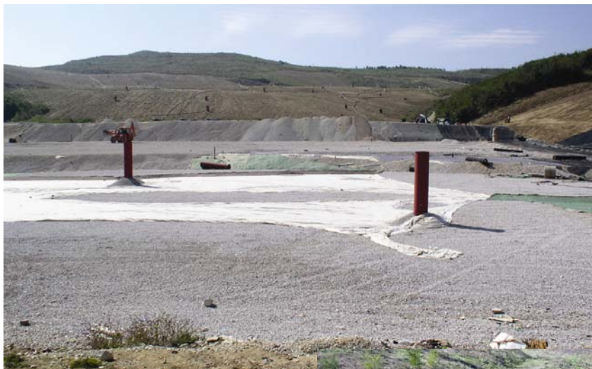
Pokrivanje novopristalog otpada nanosima zemlje i geotekstilom
