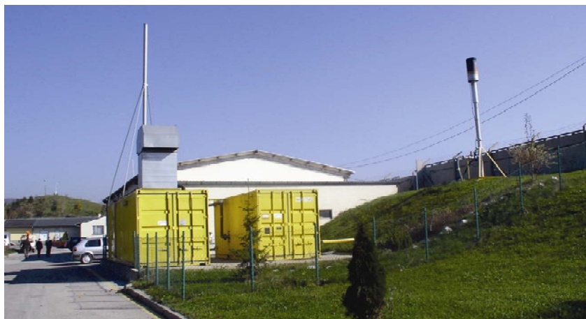
Novo postrojenje za sortiranje otpada na odlagalištu
