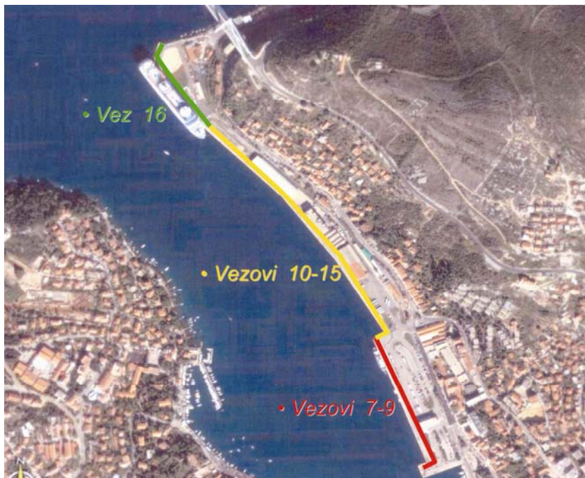
Vezovi u Gruškoj luci prije početka rekonstrukcije i obnove
