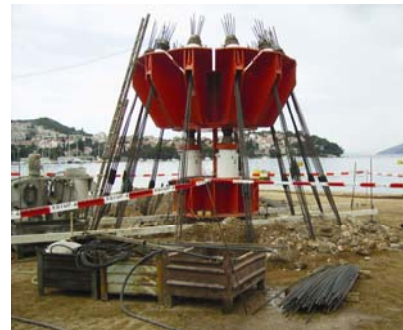
Izvedba probnog pilota
