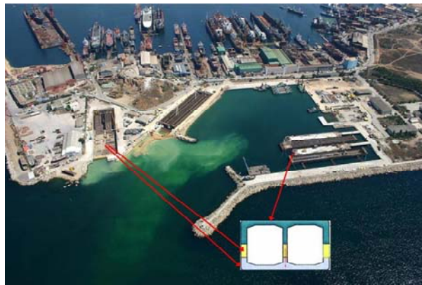
Slika 10. Pogon Tuzla za izradu elementa uronjenog tunela
