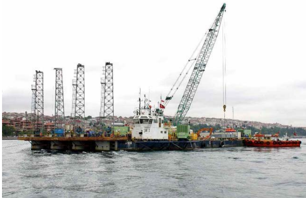
Slika 6. Postupak zbivanja injektiranjem u istanbulskom tjesnacu
