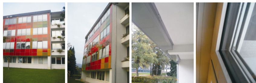
Veći dio vanjskoga plašta saniran je ugradnjom montažnih panela
