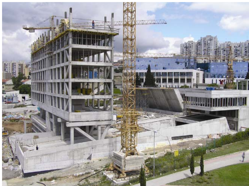
Završetak armiranobetonskih radova na gradilištu Sveučilišne knjižnice
