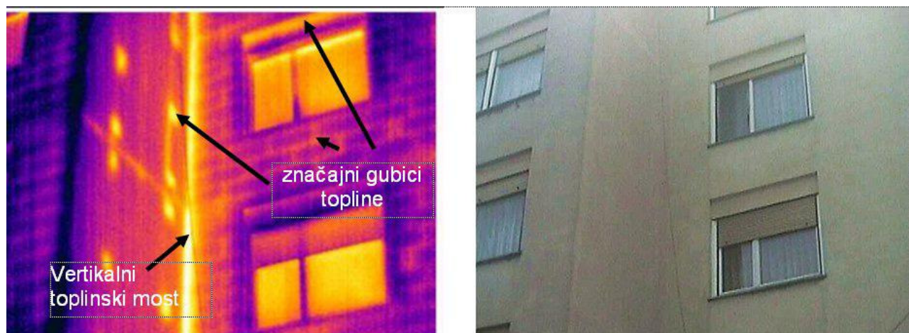
Slika 6. Termogram i fotografija dijela pročelja stambene zgrade
