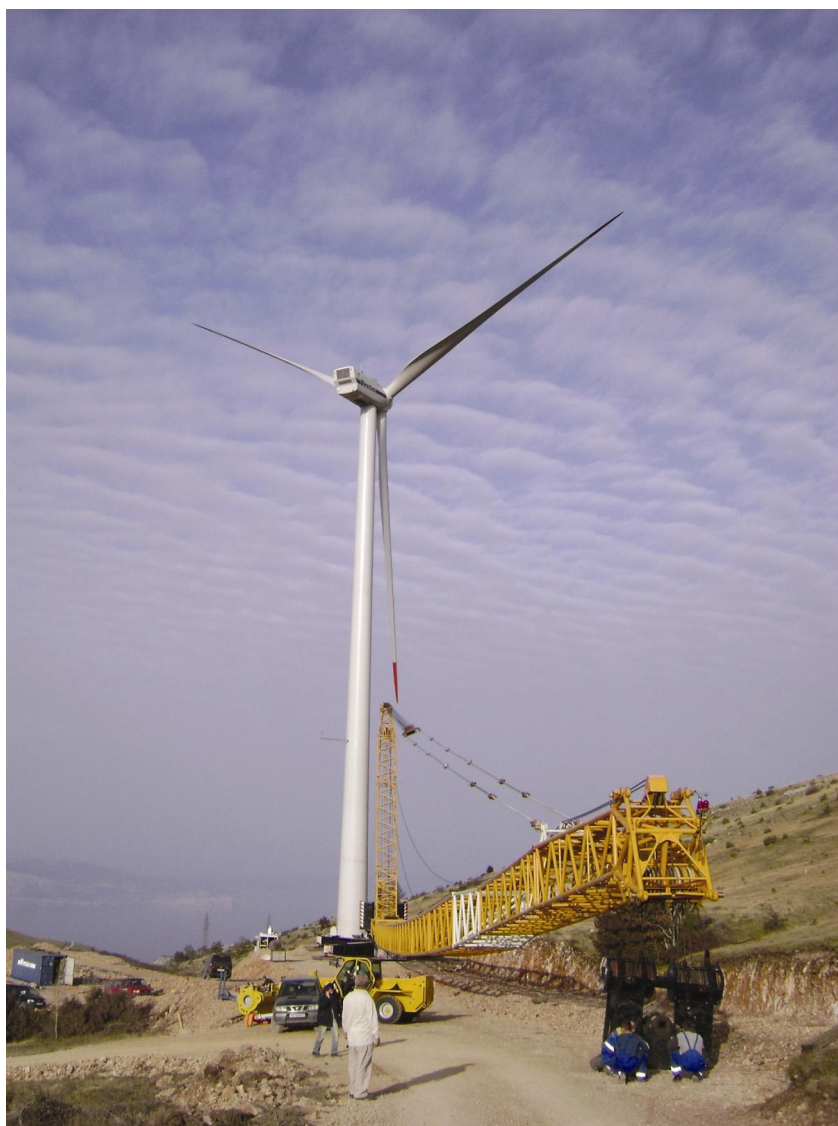
Završetak postavljanja jedne od vjetroturbina
