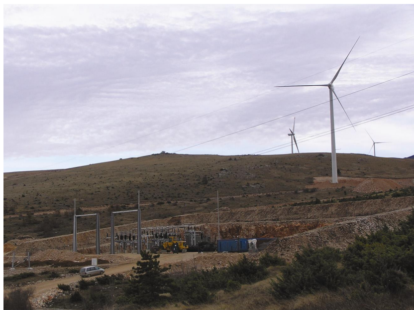
Gradnja nove trafostanice
