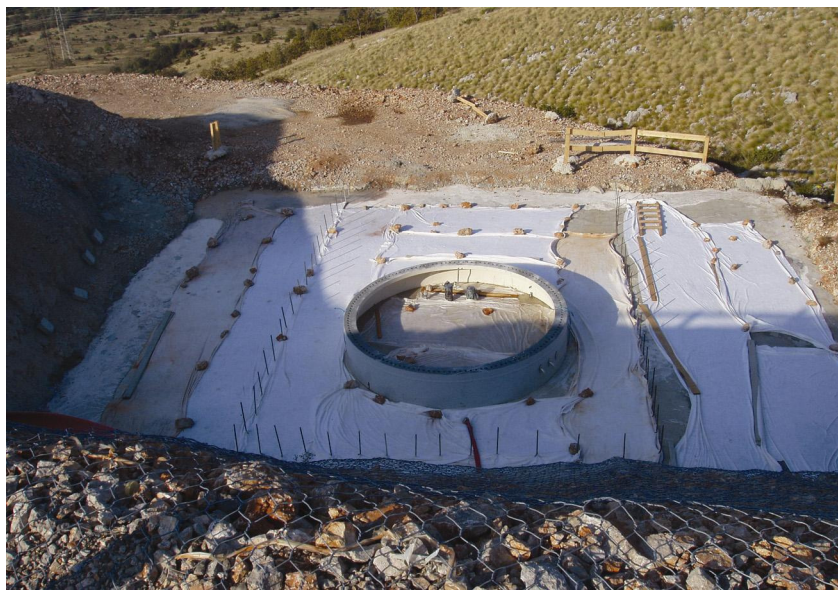
Izbetonirani temelj stupa
