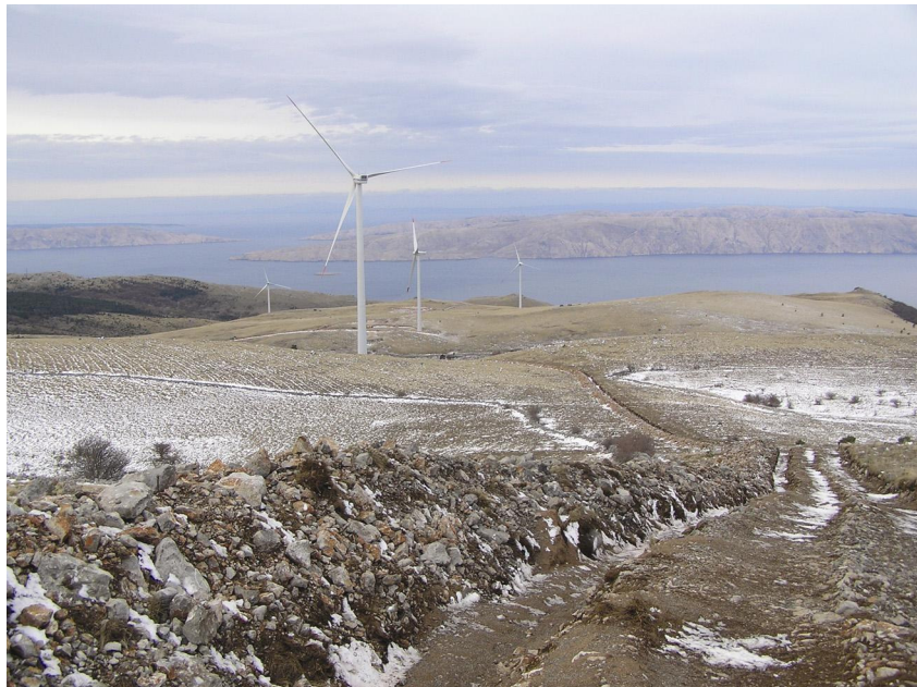
Pogled na dio vjetroturbinu Vrataruša
