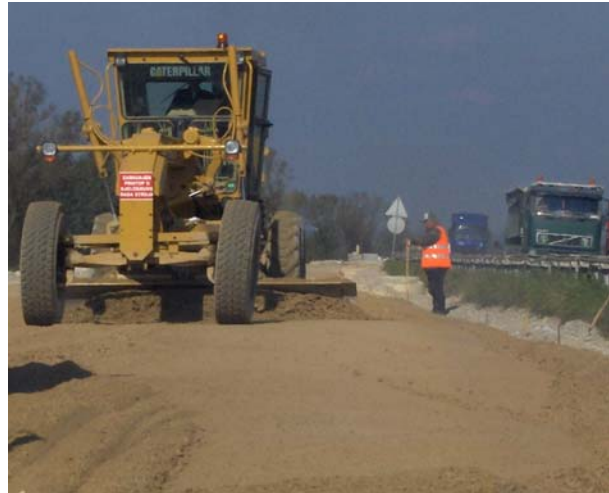
Slika 4. Razastiranje cementne stabilizacije grejderom
