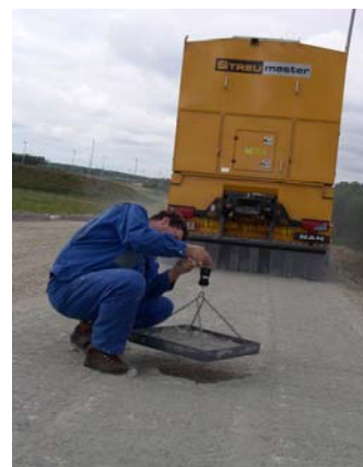
Slika 7. «Mix in place» tehnologija izvedbe sloja
