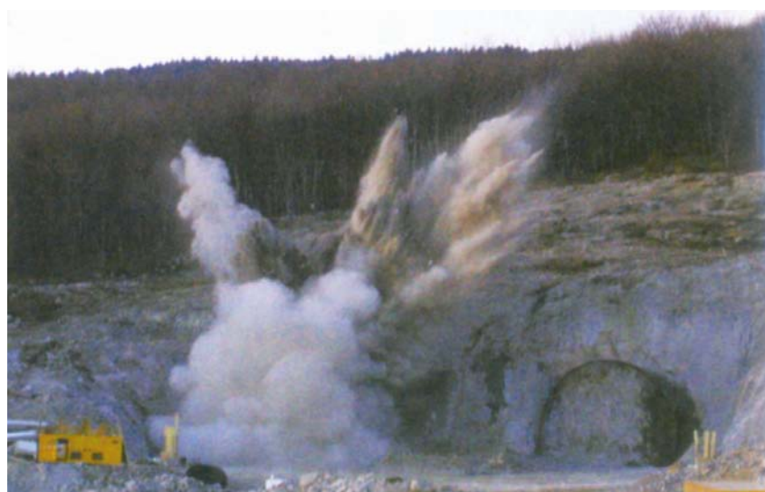
Prvo miniranje na proboju tunela Mala Kapela
