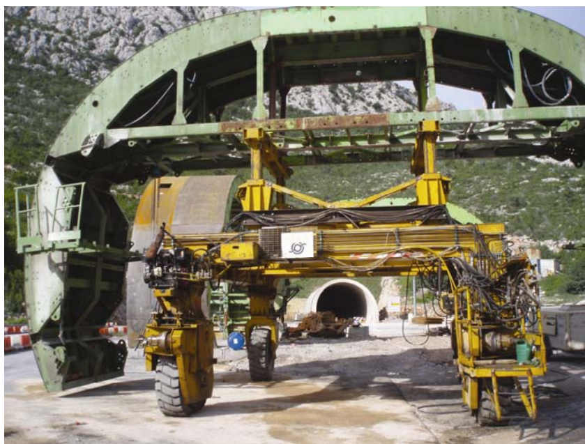
Samohodna hidraulična oplata pred južnim portalom tunela Sv. Rok
