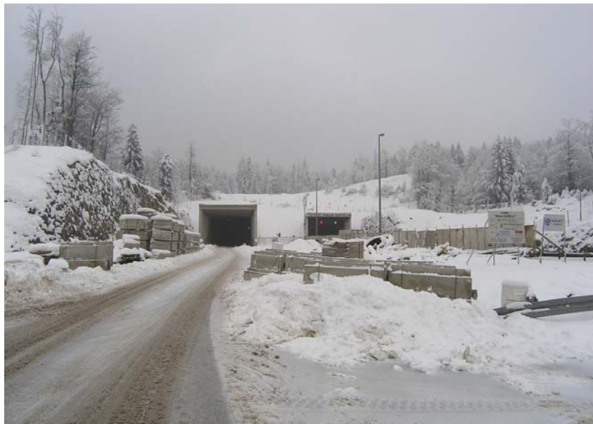
Završni radovi na sjevernom portalu tunela Mala Kapela
