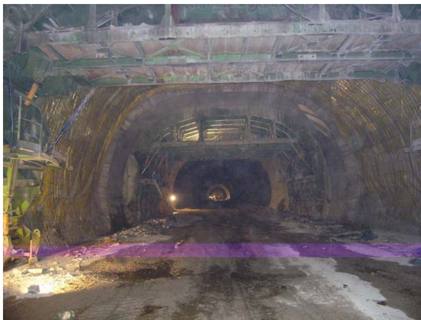
Radovi u tunelu Sv. Rok
