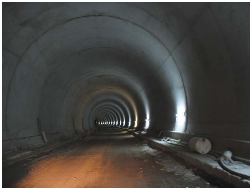
Dovršena tunelska obloga u lijevoj cijevi tunela Mala Kapela
