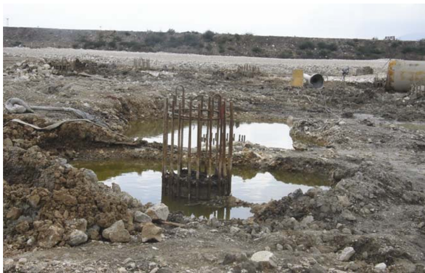
Detalj izvedbe armiranobetonskih vertikalnih pilota
