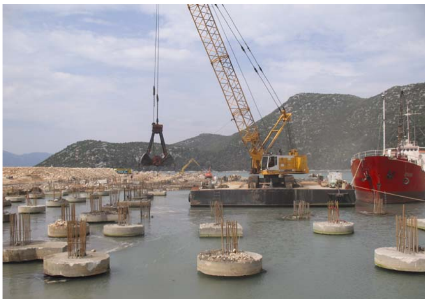
Iskop pokosa ispod obale
