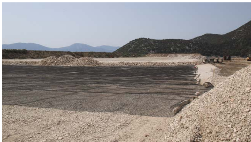
Detalj izvedbe zemljanih radova
