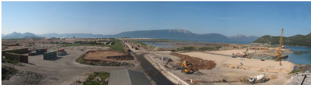
Panoramski prikaz luke i gradilišta nakon ugradnje pilota
