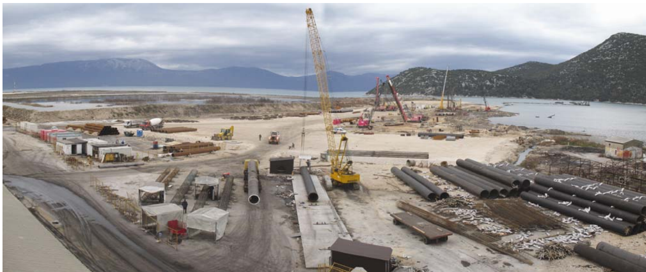
Panoramski prikaz gradilišta u početku radova
