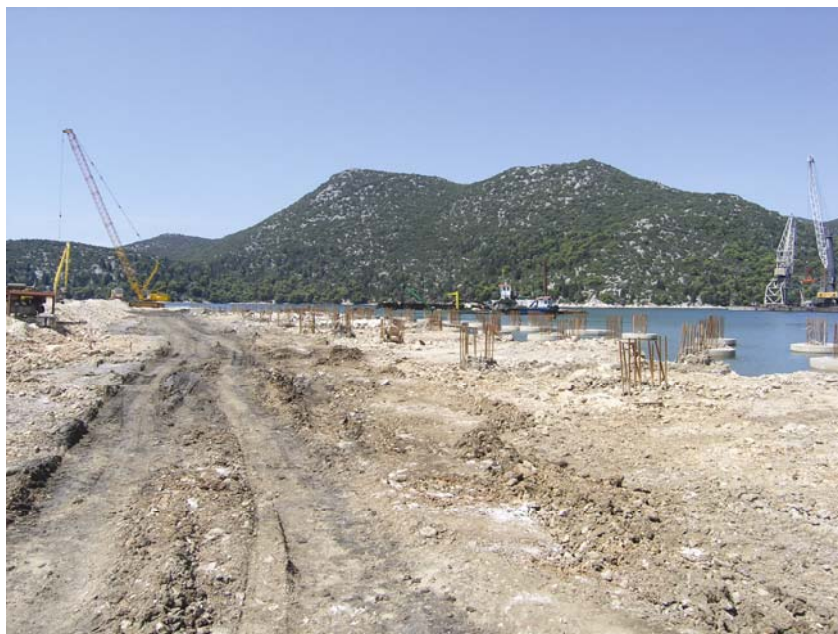
Gradilište zabilježeno tijekom posjete
