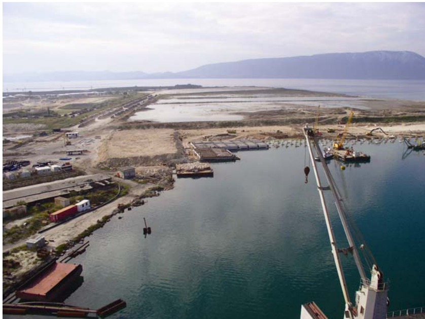
Prikaz gradilišta s dijelom ugrađenih montažnih greda i ploča
