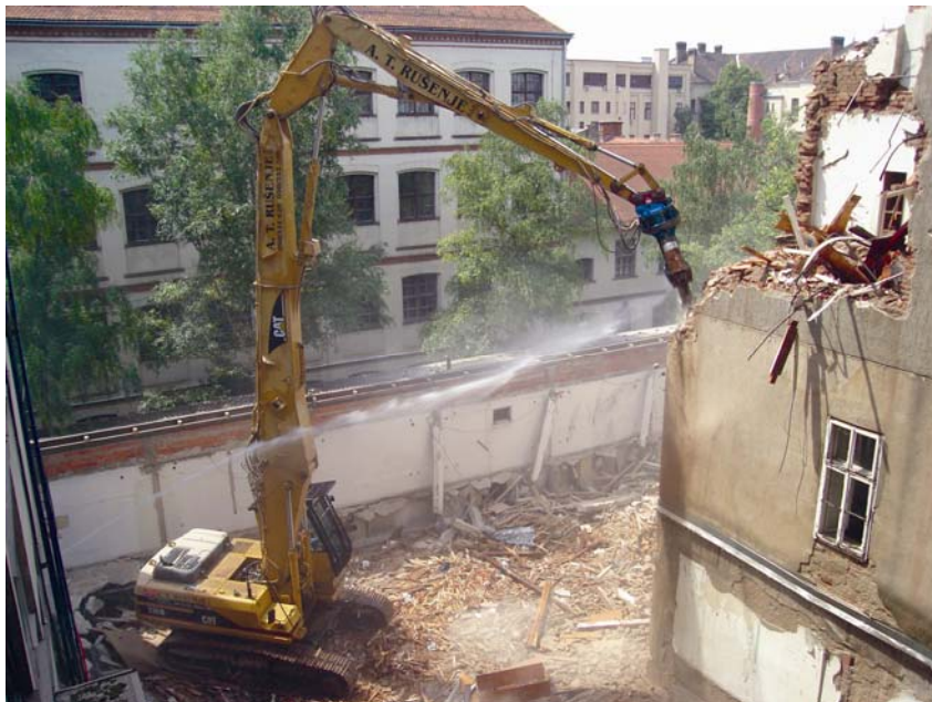
Rušenje zgrade u Prilazu Gjure Deželića
