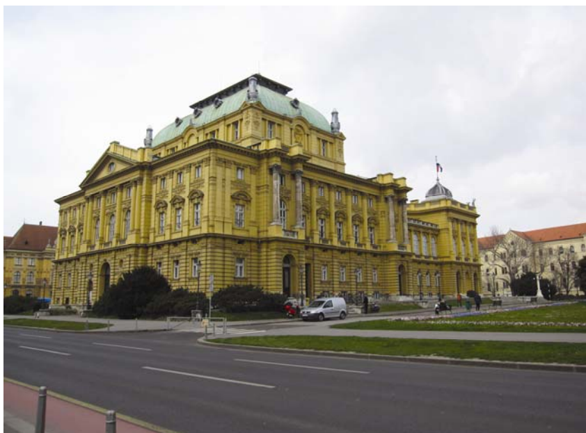
Zgrada Hrvatskog narodnog kazališta (izgrađena 1895.) potpuno dominira trgom
