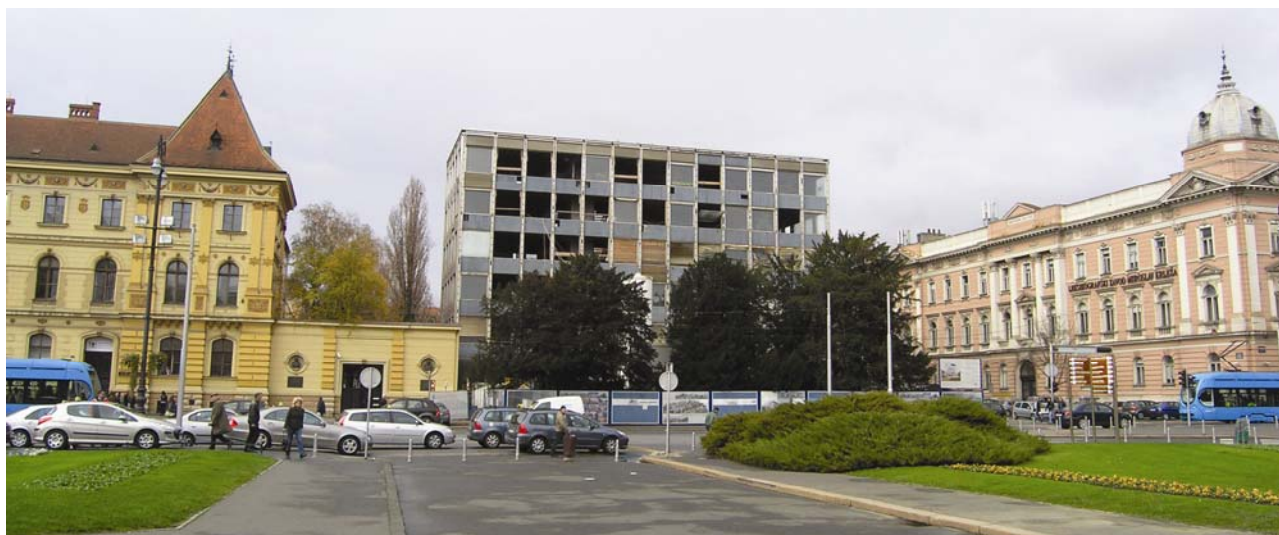
Pogled ispred kazališta na gradilište
