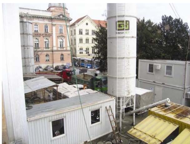
Uprava gradilišta ispred zgrade Ferimporta
