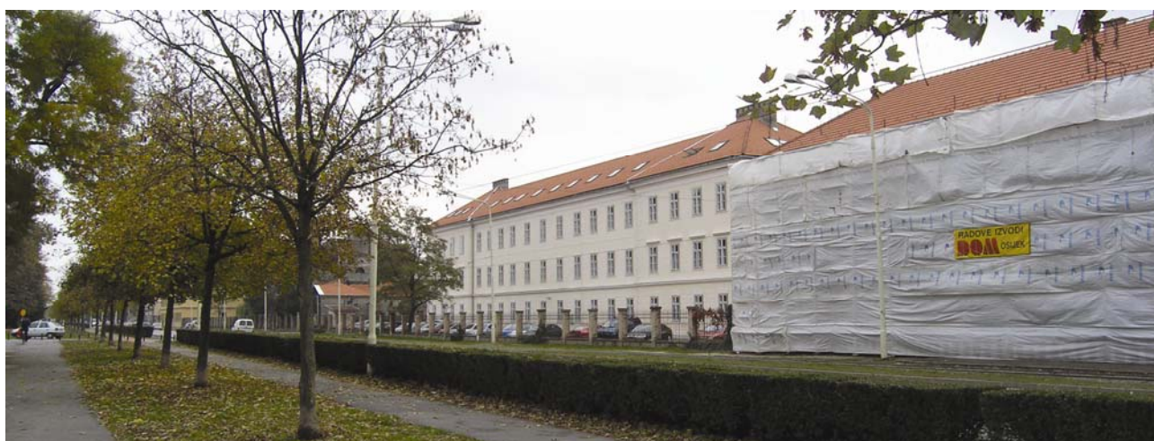
Pogled na obnovljenu zgradu Elektrotehničkog fakulteta i zgradu dekanata Učiteljskog fakulteta tijekom obnove
