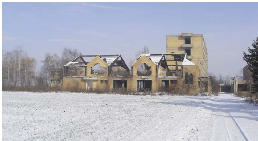
Dio zgrada Biotehničkoga znanstveno-nastavnog centra na Tenjskoj cesti
