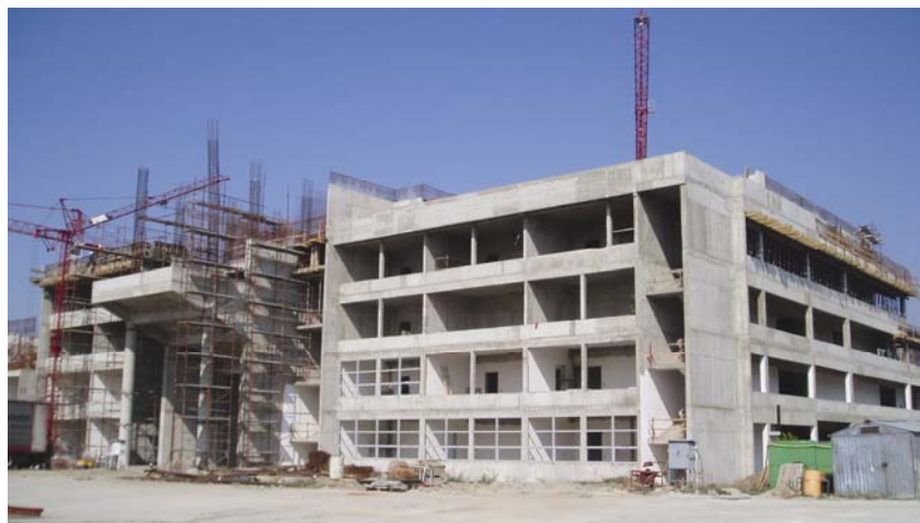
Južno pročelje zgrade Poljoprivrednog fakulteta u gradnji
