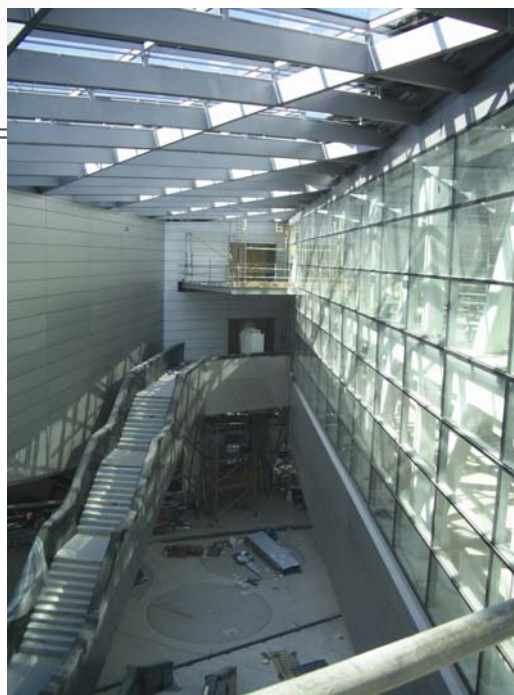
Interijer građevine tijekom radova
