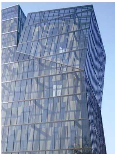
Bojano staklo na pročelju zgrade kampusa San Joaquin Universidad Catolica de Chile u Santiagu
