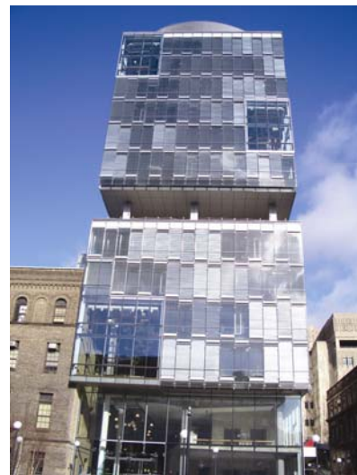
Stakleno pročelje s elementima zaštite od sunca na zgradi Terrence Donnelly Centra za molekularna istraživanja Univerziteta u Torontu
