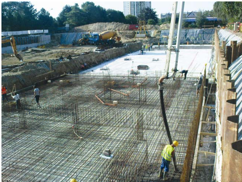
Betoniranje temeljne ploče bazenskog kompleksa
