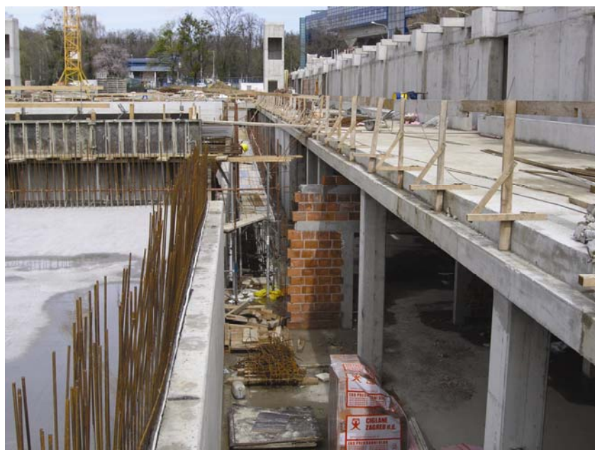
Gradnja pobočnih dijelova građevine
