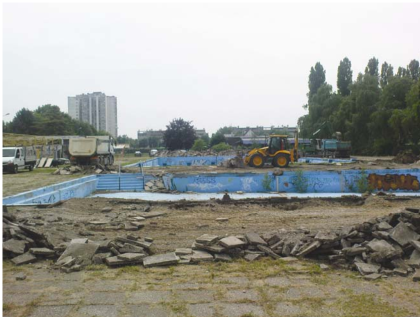
Početak radova i rušenje prijašnjih bazena
