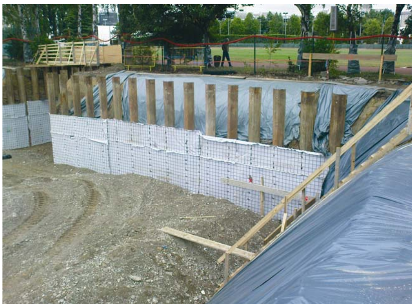
Zaštita građevne jame žmurjem
