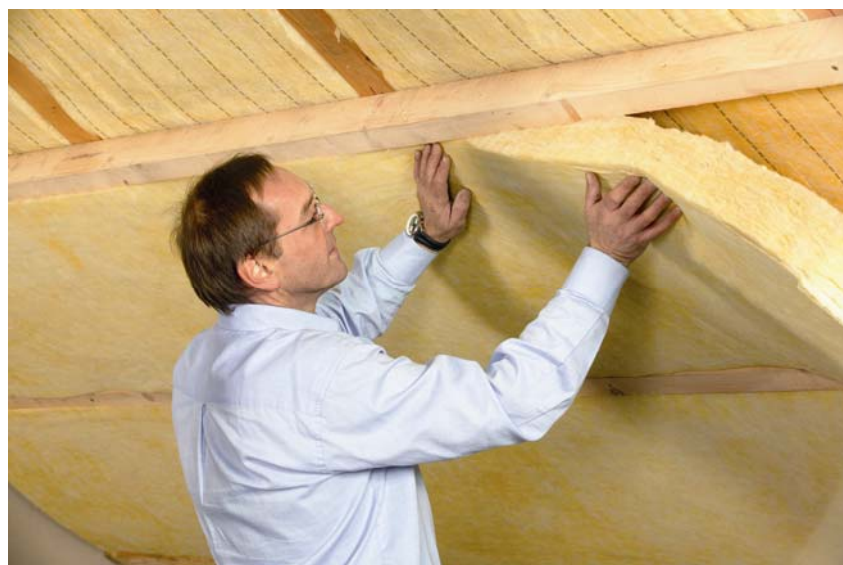
Montaža toplinske izolacije od staklene vune
