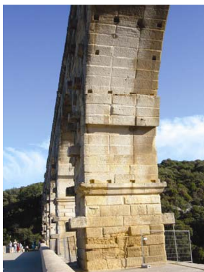
Pogled na intrados jednog od lukova mosta
