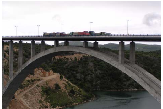
Probno ispitivanje mosta Krka kod Skradina
