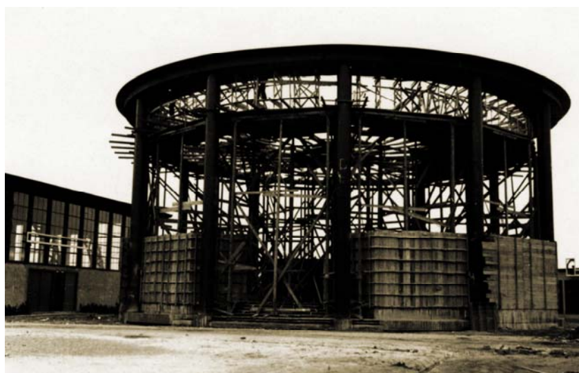
Gradilište paviljona u fazi pripreme za gradnju krovne konstrukcije
