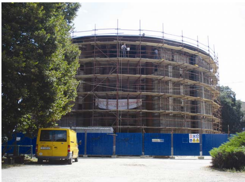
Montirana skela za obnovu Francuskog paviljona
