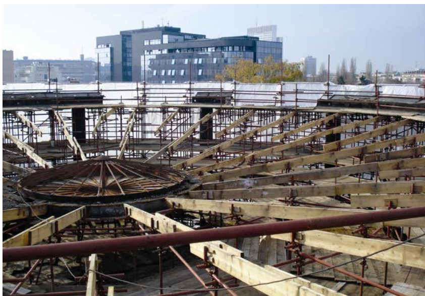
Završetak demontaže pokrova
