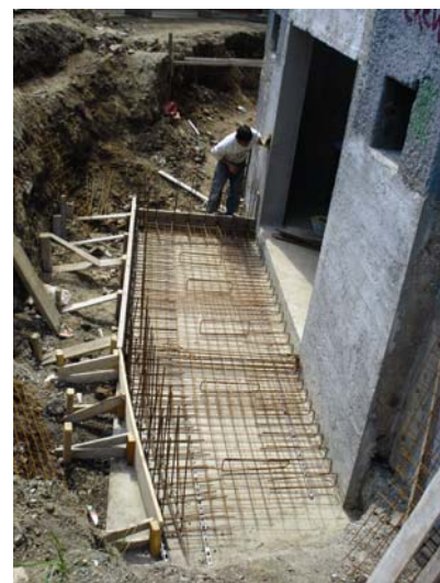
Sanacija i ojačavanje temelja
