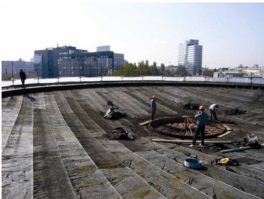
Radovi na demontaži pokrova
