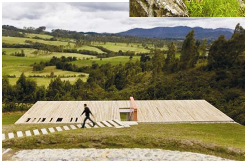
Ulaz s krova u obiteljsku kuću
