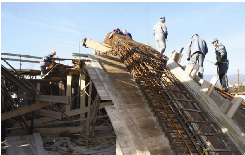
Pripreme za betoniranje
