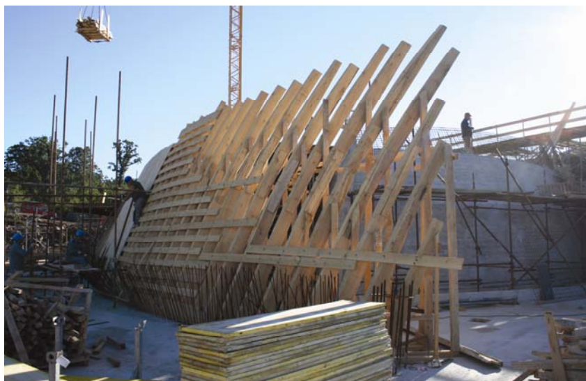
Prva faza izvedbe kupole
