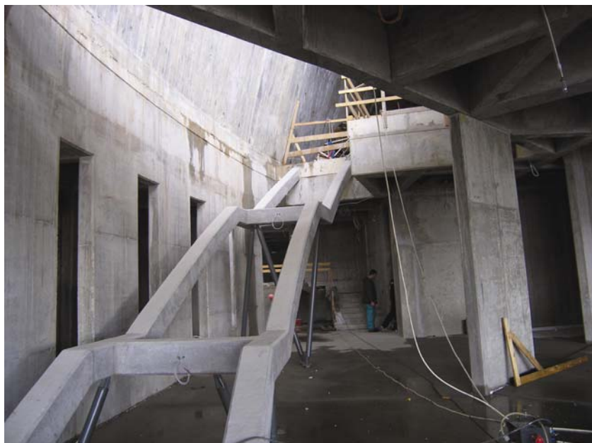
Stubište koje će spajati molitveni prostor s razinom -1
