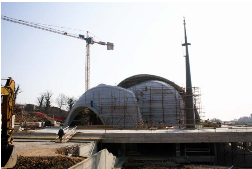
Osnovna je konstrukcija Islamskog centra uglavnom završena
