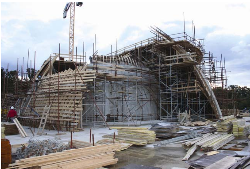
Ručno izradena oplata za betoniranje kupola
