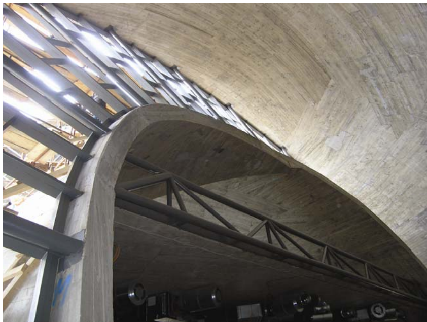
Čelična konstrukcija spojeva među kupolama
