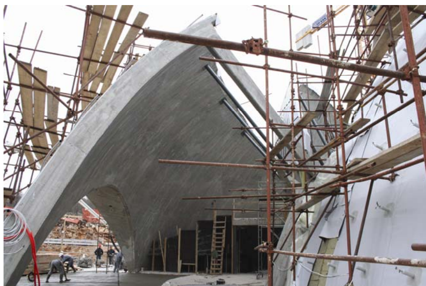
Uklanjanje skela i podupirača
