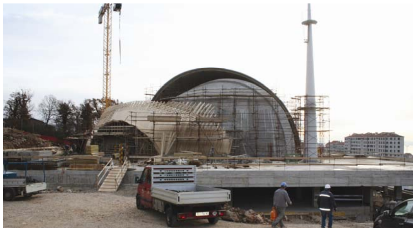
Pripreme za betoniranje ulaznog dijela
