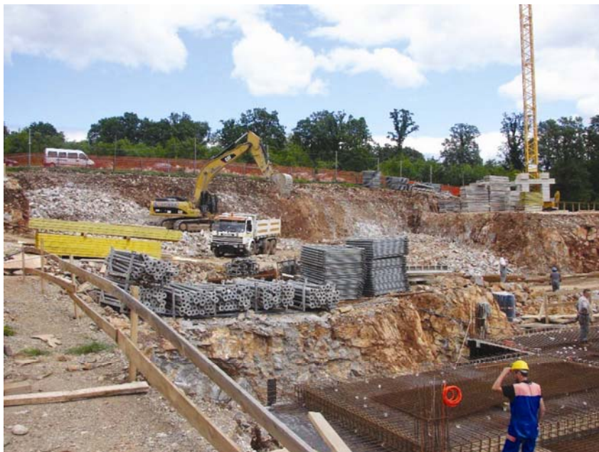
Početak građevinskih radova na lokaciji
