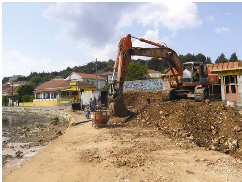
Gradnja glavne crpne stanice pokraj lječilišta Kalos
