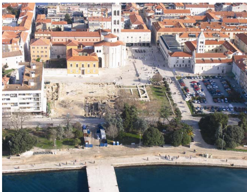
Gradnja kanalizacijskog kolektora na zadarskoj rivi
