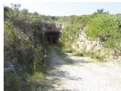
Sjeverni portal hidrotehničkog tunela Vira
