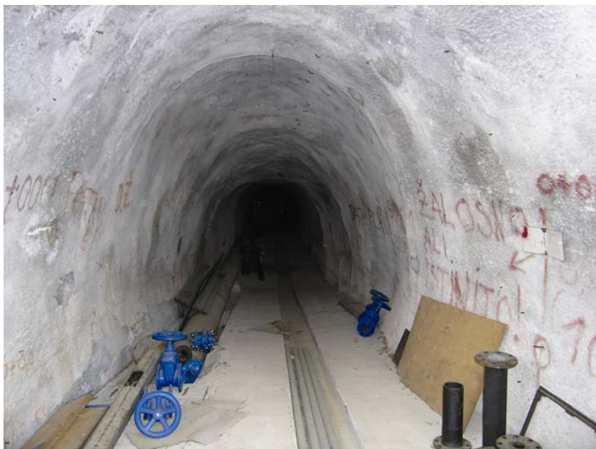
Unutrašnjost hidrotehničkog tunela u Veljoj Luci
