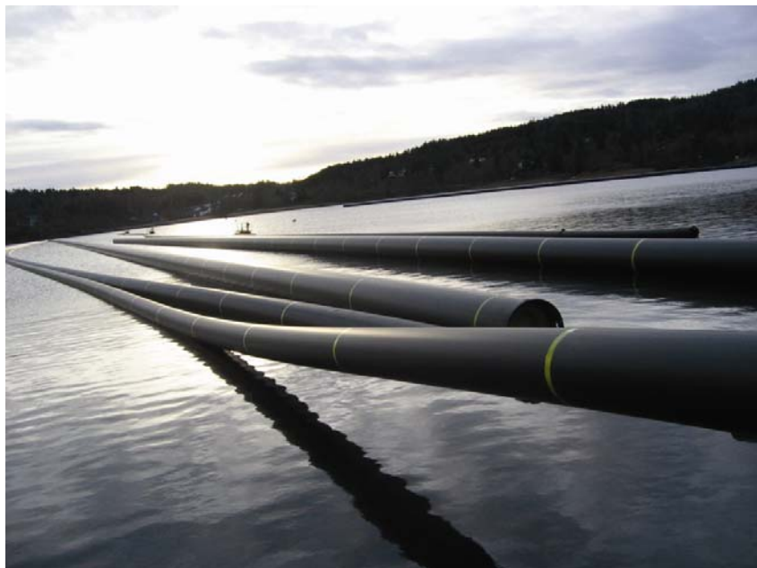
Cijevi za podmorski ispušt kanalizacionog sustava Biogradske rivijere
