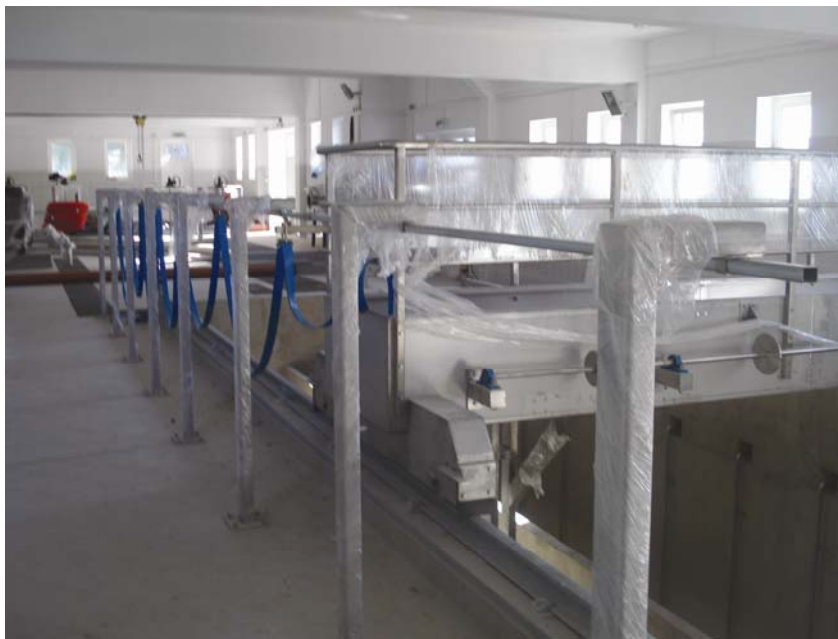
Ugradnje opreme u Uređaj za pročišćavanje otpadnih voda u Makarskoj
