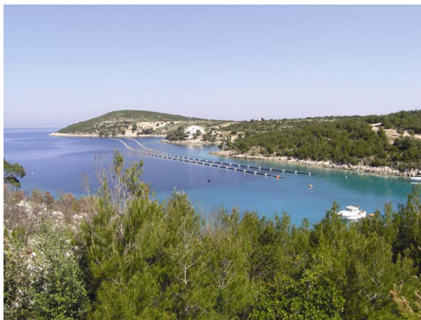
Cijevi za podmorski ispust u uvali Pribinja
