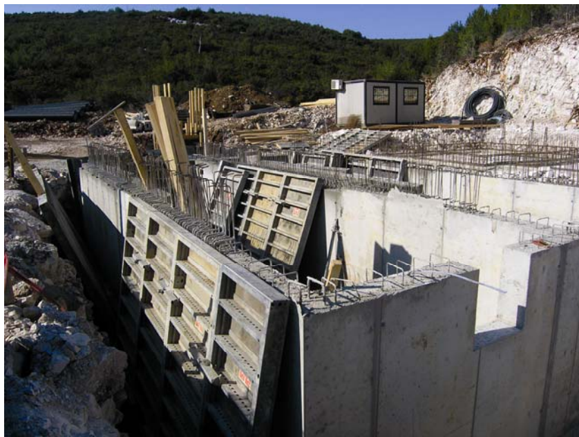
Gradilište uređaja za pročišćavanje u uvali Vira
