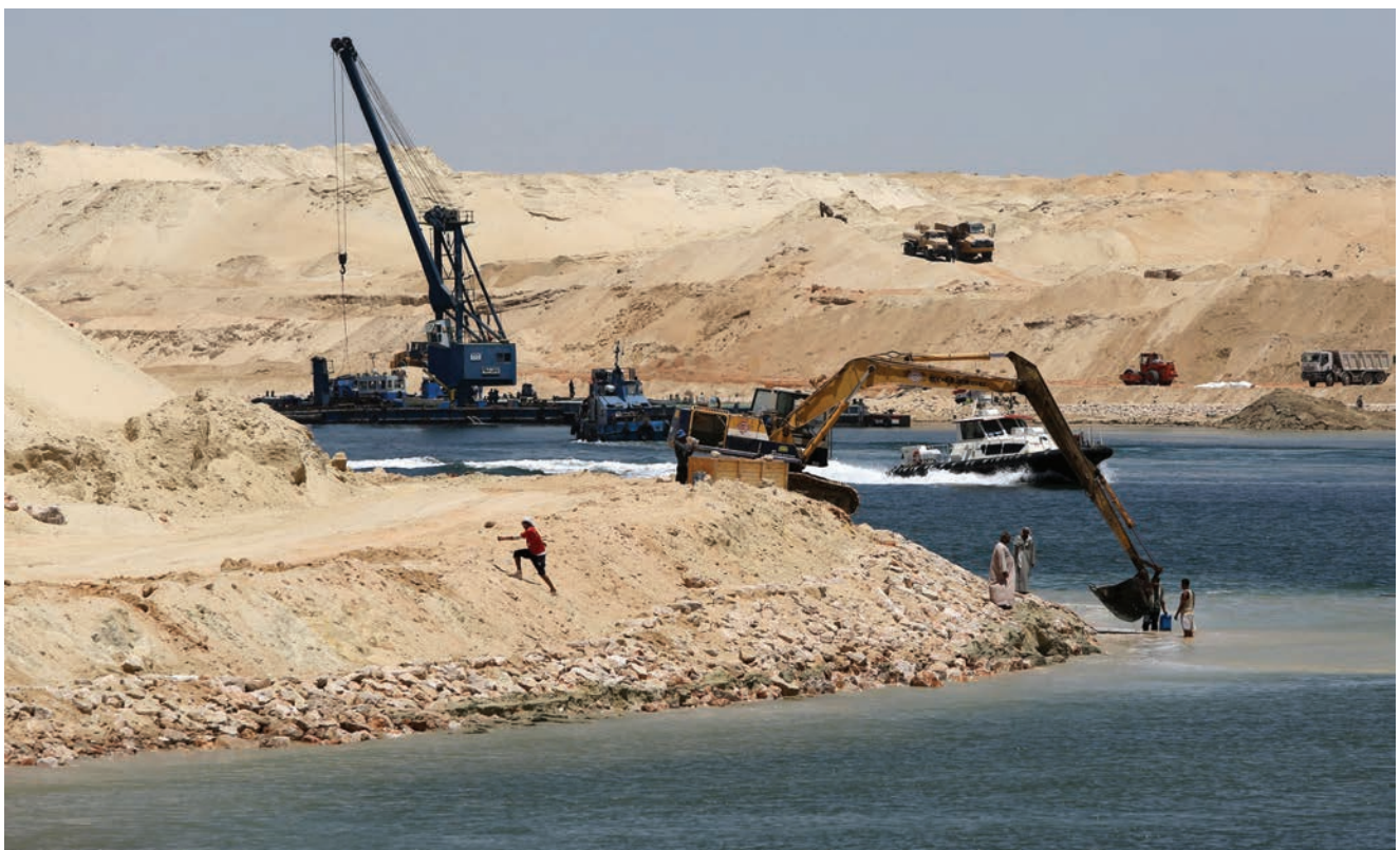
Detalj s gradilišta
