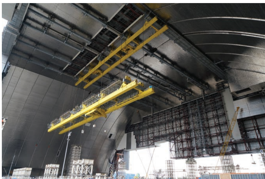
Pomoću dizalica uklonit će se stari betonski sarkofag
