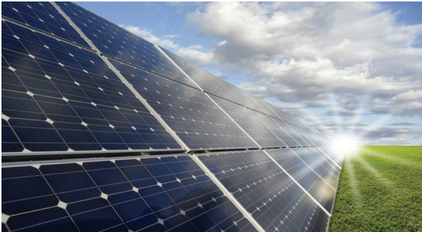
Zona isključenja iskoristit će se za postavljanje solarnih panela
