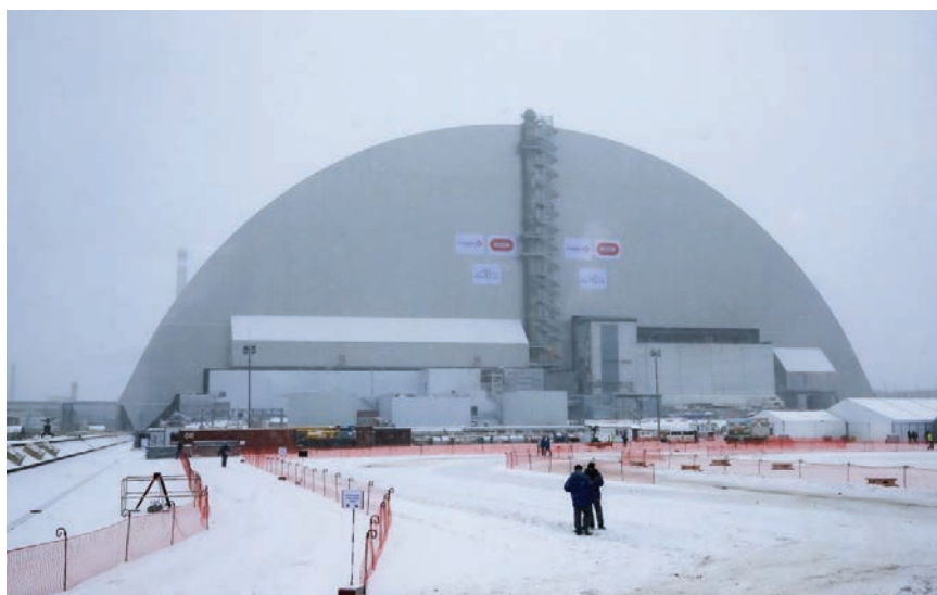
Zaštitna kupola postavljena je preko staroga betonskog sarkofaga
