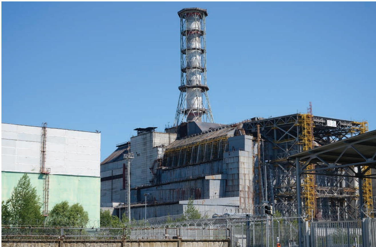
Pogled na reaktor na kojemu je izgrađen betonski sarkofag
