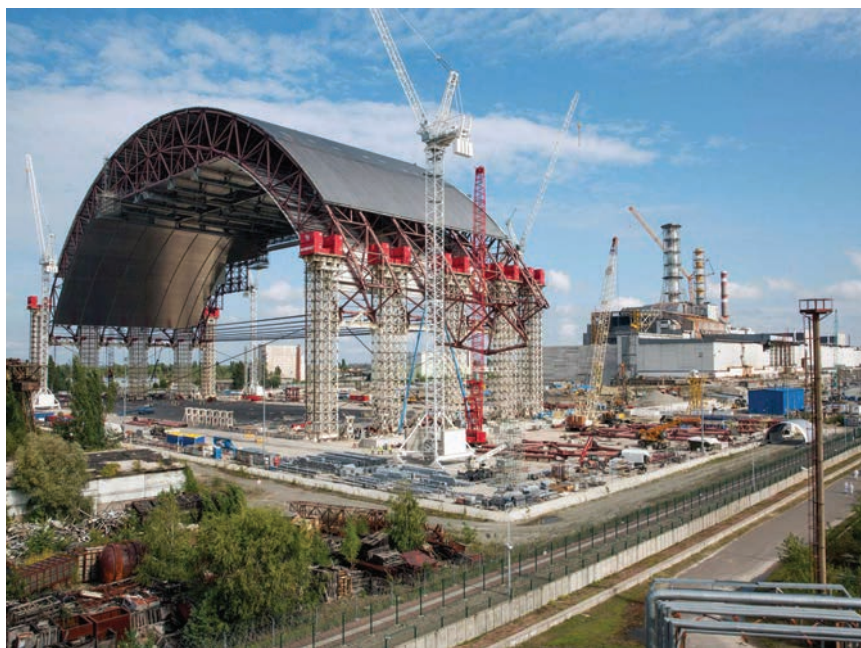
Detalj s gradilišta
