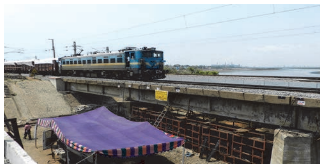
Slika 8. Željeznički most na kojem je ugrađen bežični sustav za mjerenje deformacija
