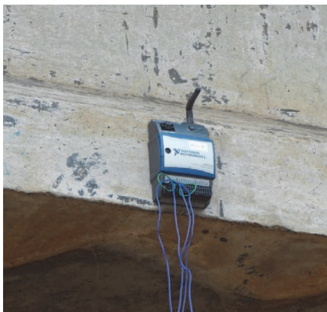
Slika 10. Bežični senzorski čvor ugrađen na mostu
