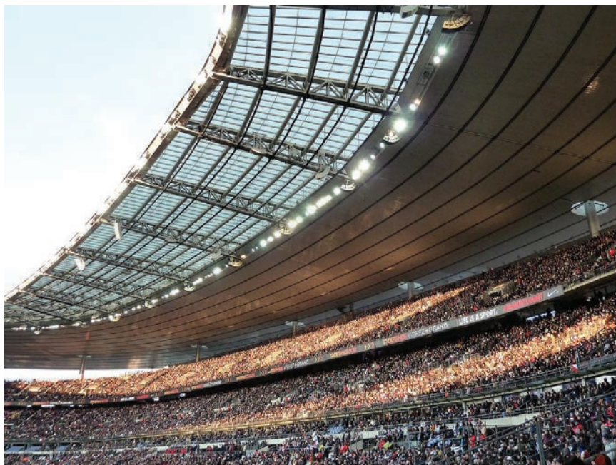
Rasvjeta s donje strane krovne konstrukcije stadiona Stade de France
