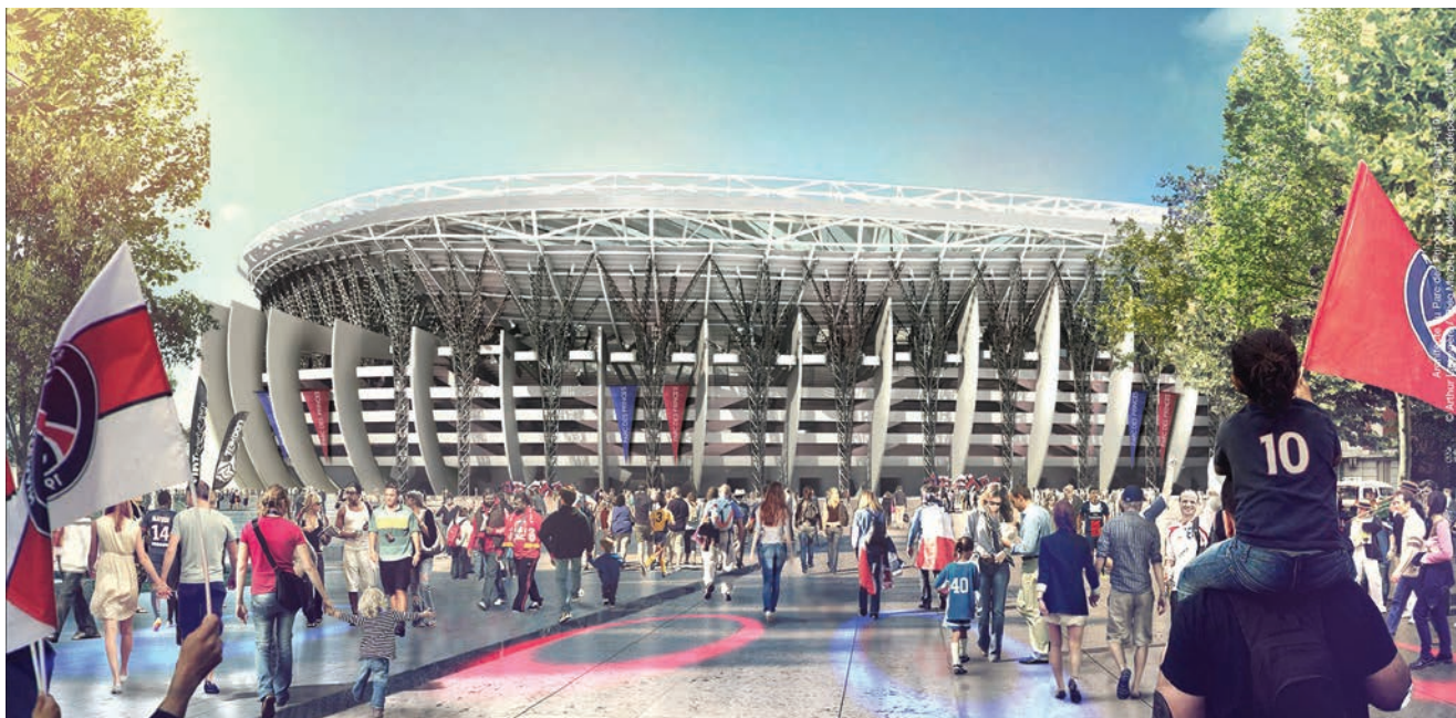
Dizajn Parka prinčeva u budućnosti prati poznatu strukturu betonskih rebara koju natkriva nova krovna konstrukcija
