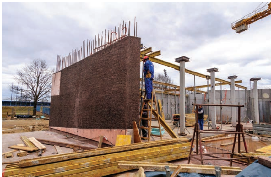
Fasada je izvedena metodom pranog kulira
