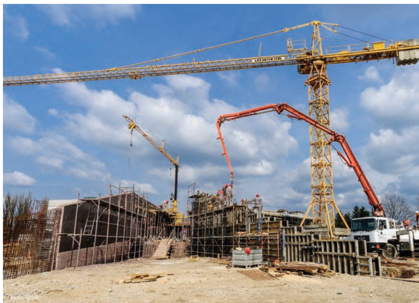
Betoniranje druge etaže akvarija
