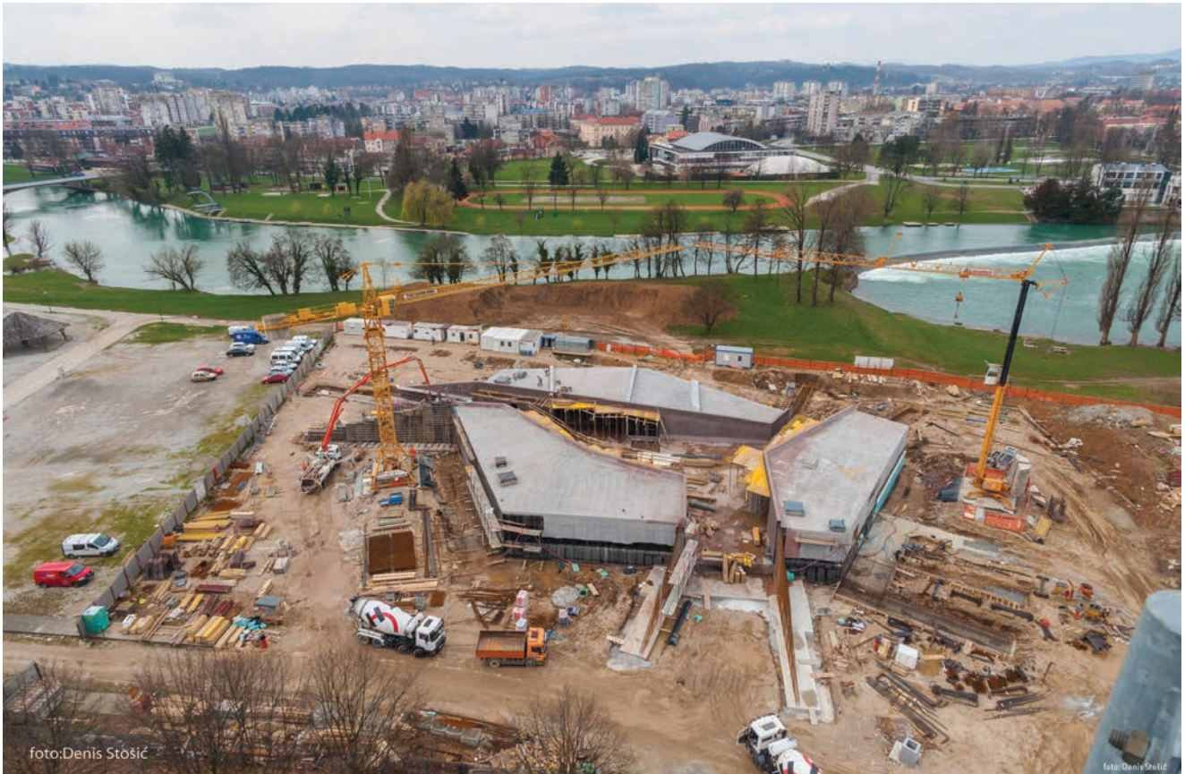
Detalj s gradilišta
