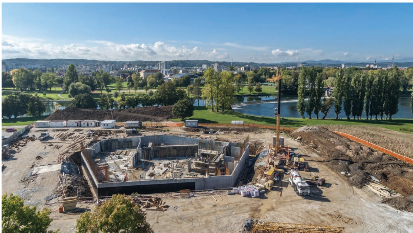
KAquarium se gradi uz obalu rijeke Korane
