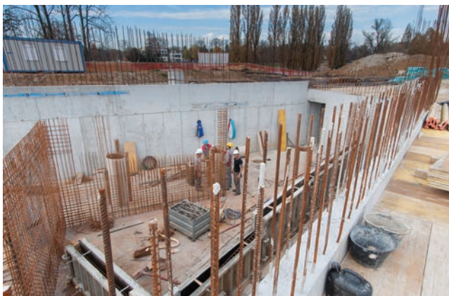
Armirački radovi na prvoj etaži
