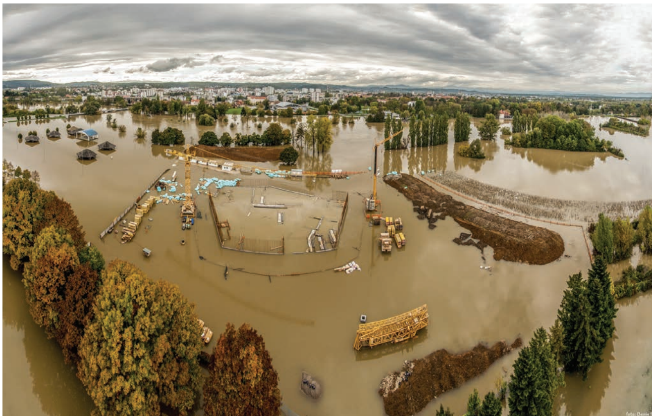
Gradilište tijekom poplave u listopadu 2015.
