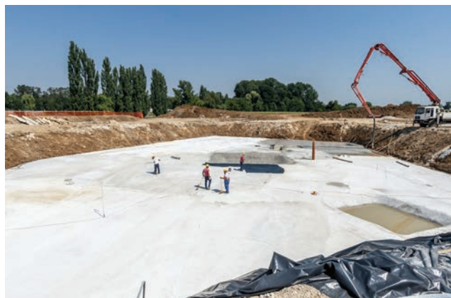
Betoniranje temeljne ploče
