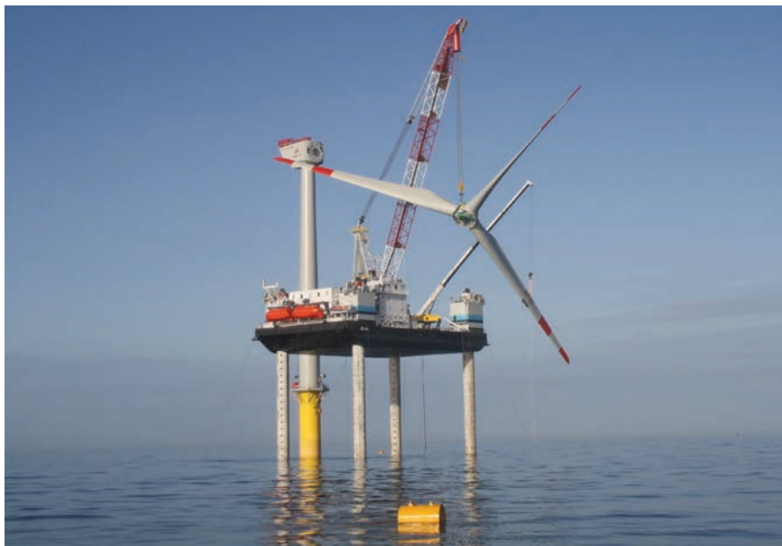
Montaža lopatica na priobalnoj vjetroelektrani
