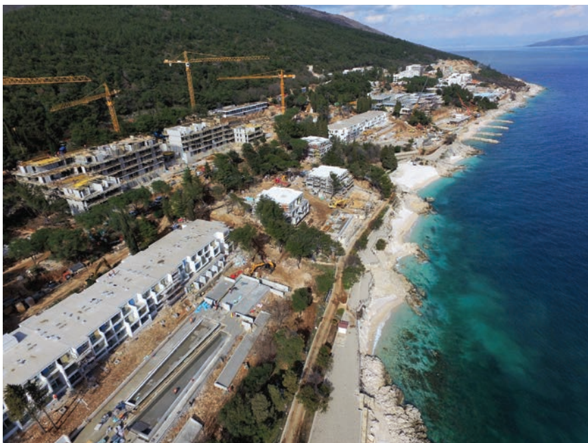
Pogled na gradilište u Rapcu
