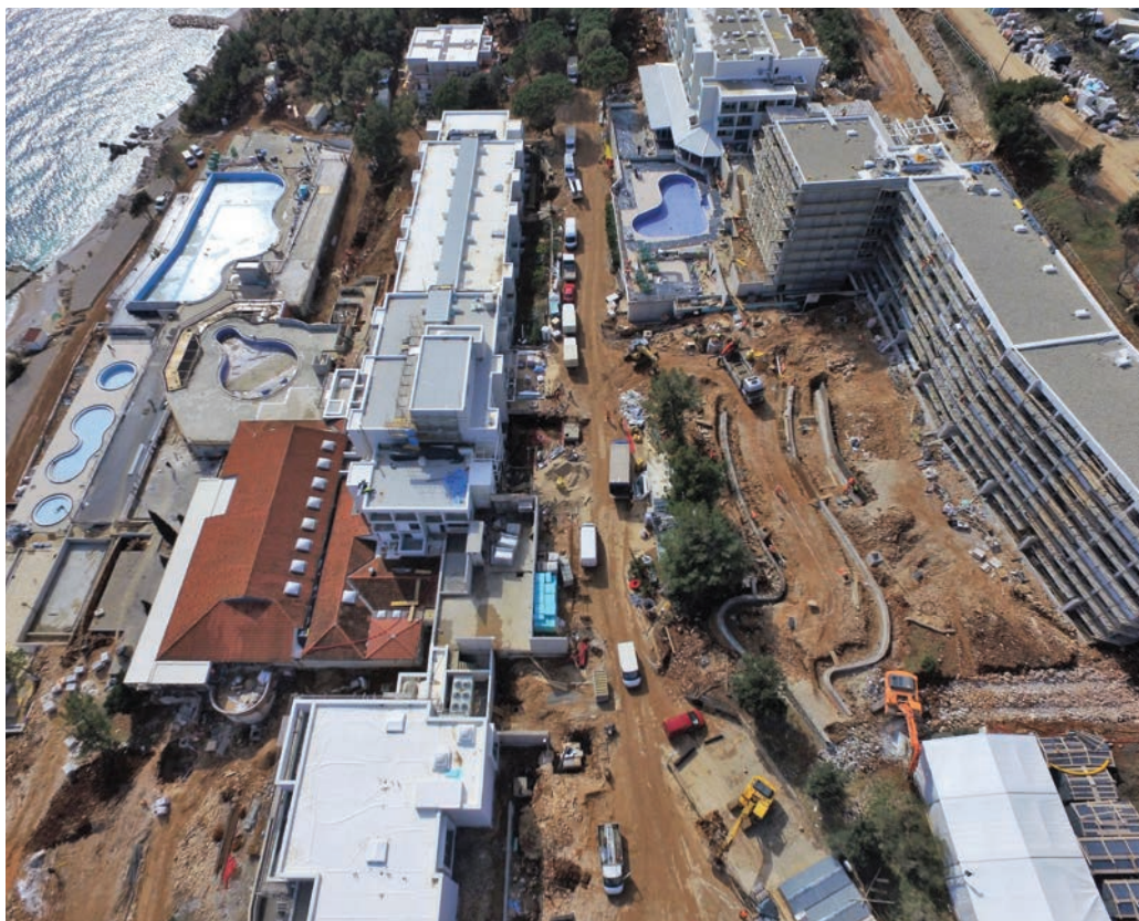
Pogled na gradilište iz zraka
