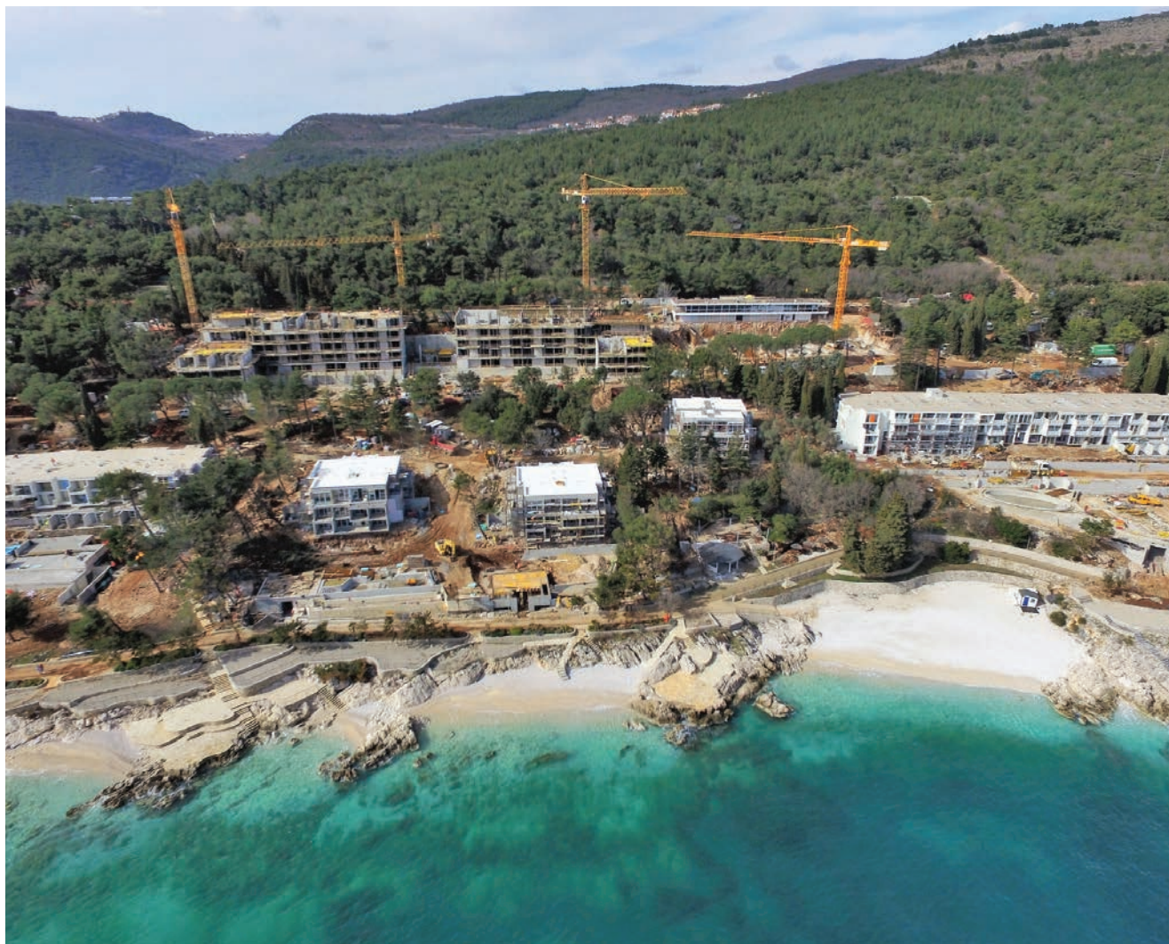
Pogled na gradilište novog ljetovališta
