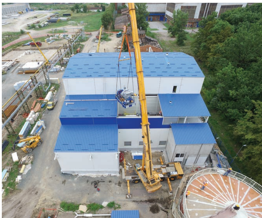
Ugradnja turbine
