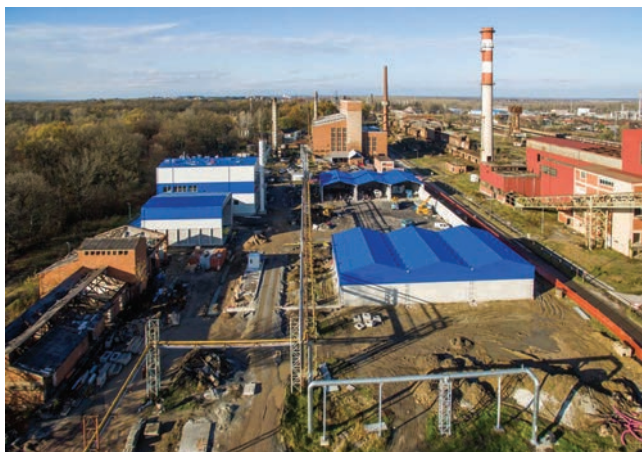
Pogled na gradilište u Sisku
