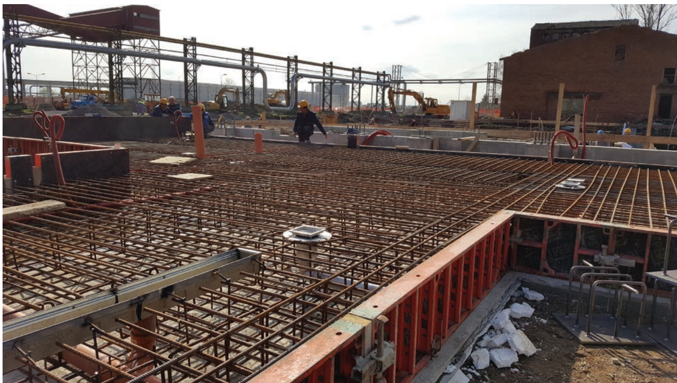
Armiranobetonski radovi na gradilištu pogonske zgrade
