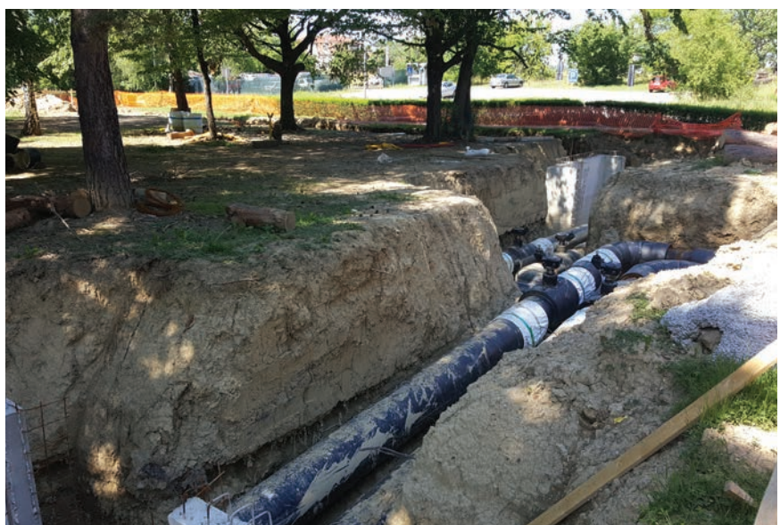
Ugradnja cijevi za vrelvod
