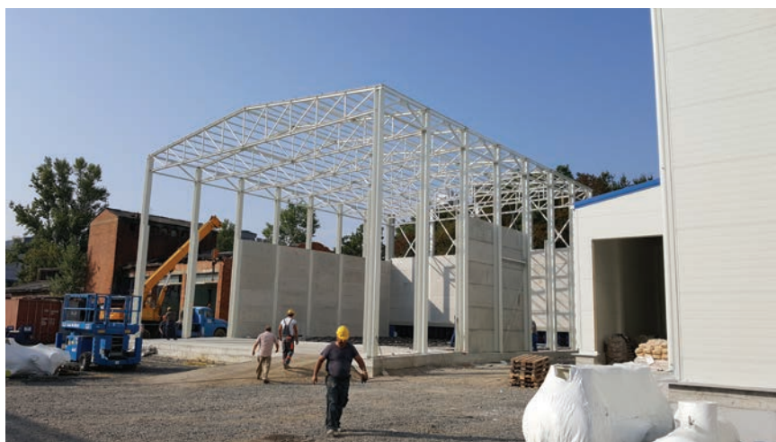
Detalj s gradilišta
