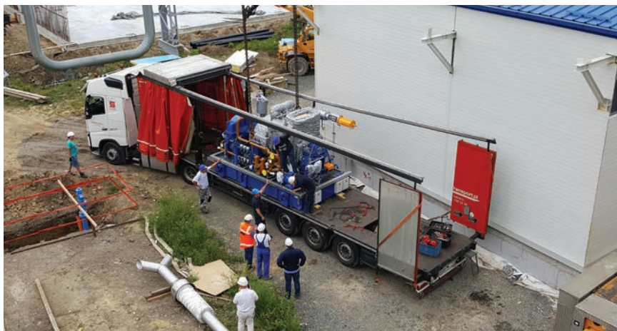
Dopremanje turbine na gradilište
