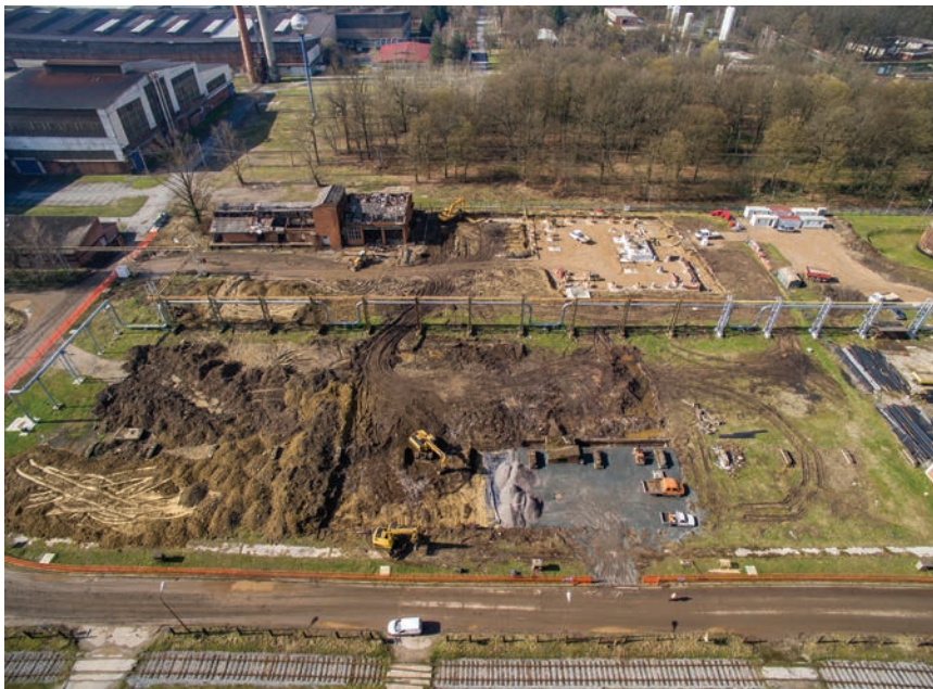
Pripremni radovi na gradilištu BE-TO Sisak
