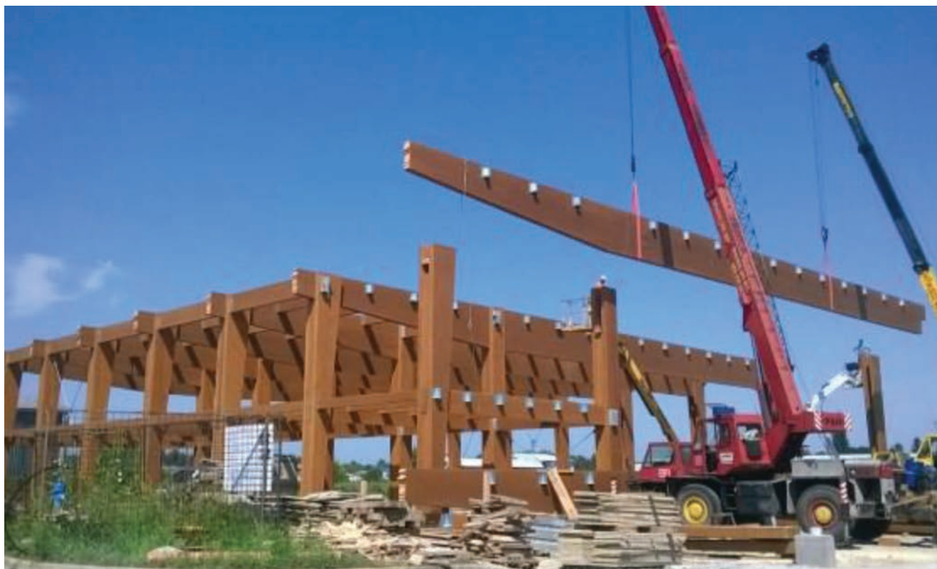
Izvedba konstrukcije građevine
