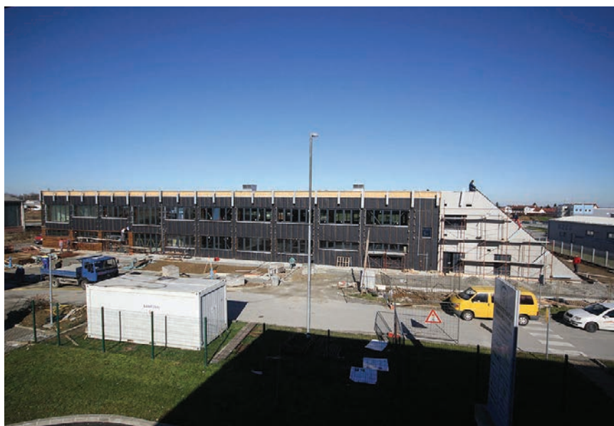
Radovi na pročelju zgrade
