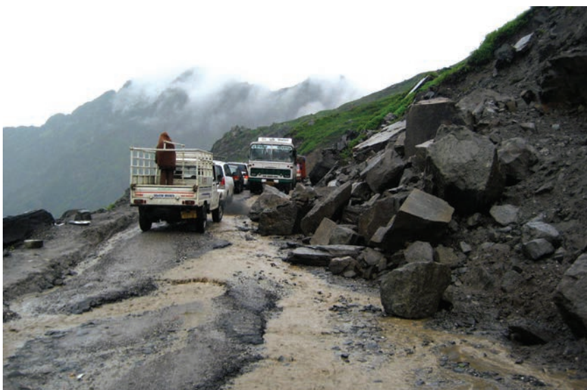
Pogled na cestu preko prijevoja Rohtang
