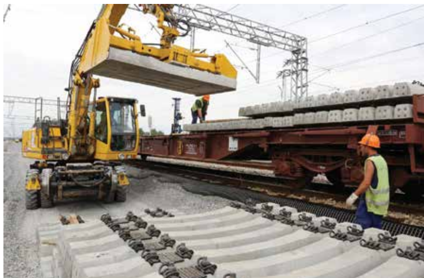
Radovi na modernizaciji željezničke pruge
