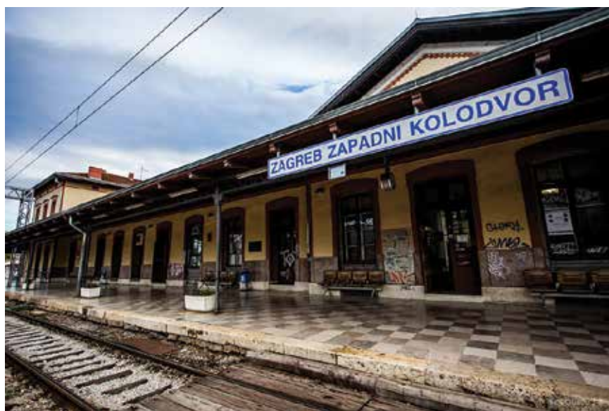
U veljači 2020. potpisan je ugovor za radove na dionici Zagreb Zapadni kolodvor – Savski Marof
