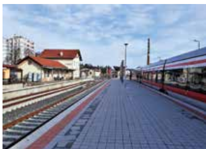
Trenutačno se izvode radovi i na dionici pruge Zaprešić- Zabok
