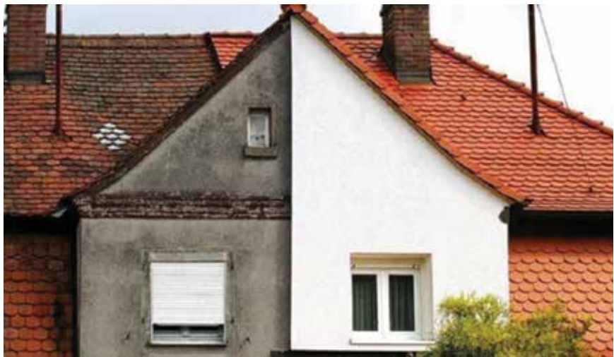
Kuća prije i nakon energetske obnove
