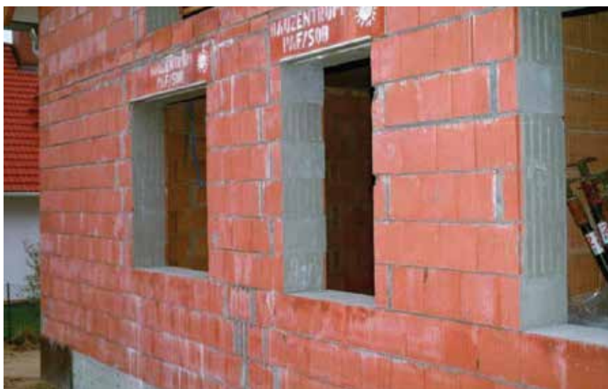
Pripremljeni otvori za montažu - glatko obrađene špalete
