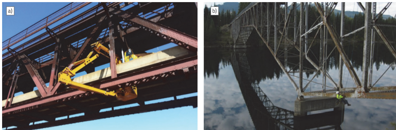
Slika 1. Vizualni pregledi mostova: a) upotrebom pristupnih vozila; b) upotrebom pristupne opreme [1]
